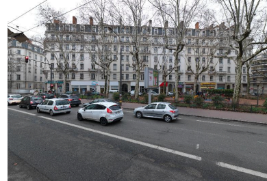
La place, partie est, vue depuis le nord Phot. Franck Trabouillet IVR84_20186900185NUCAQ
