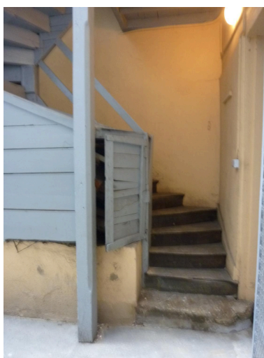
Détail escalier Phot. Nadine Halitim-Dubois IVR84_20186901395NUCA
