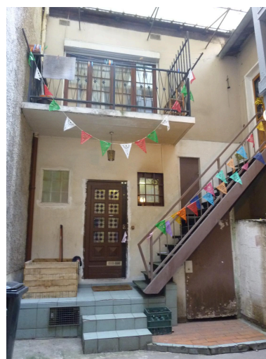
Vue de la façade sur cour Phot. Nadine Halitim-Dubois IVR84_20186901390NUCA
