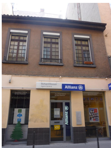
Immeuble du 6 rue du Mail escalier commun au n°8 Phot. Nadine Halitim-Dubois IVR84_20186901388NUCA
