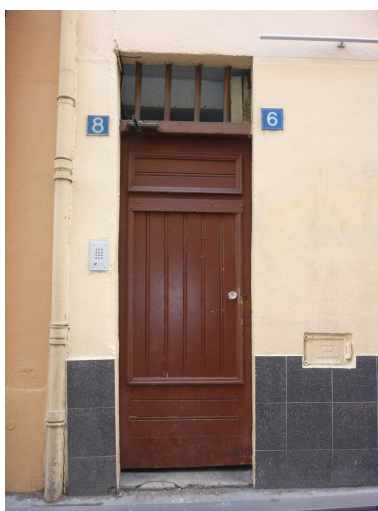
Porte piétonne Phot. Nadine Halitim-Dubois IVR84_20186901389NUCA
