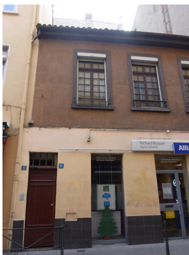
Façade principale Phot. Nadine Halitim-Dubois IVR84_20186901396NUCA
