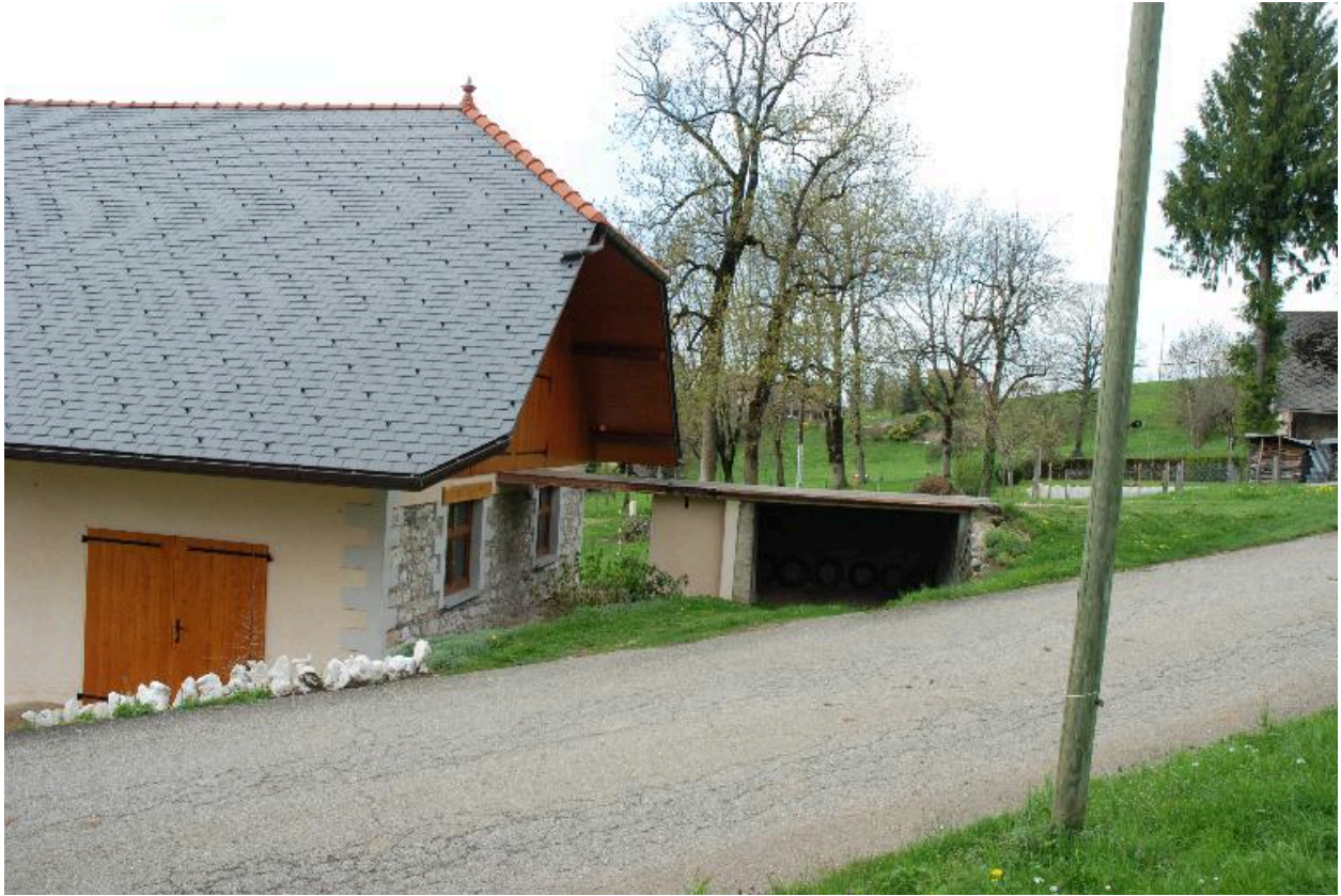
Vue de la partie amont : pont vers le fenil.
