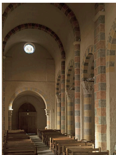
La nef centrale vue de trois-quarts, en direction de l'entrée. Phot. Jean-Michel Périn IVR83_20116301428NUC4A
