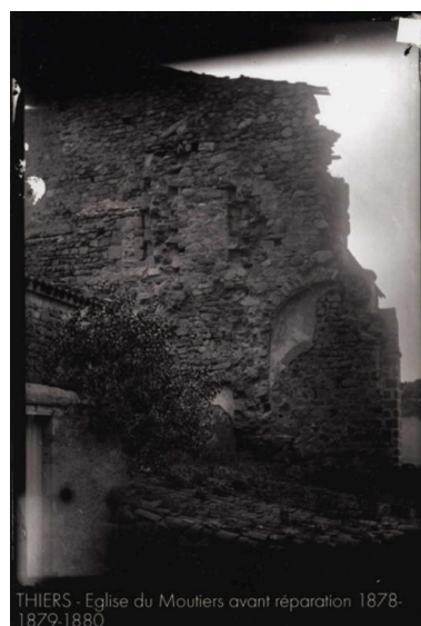
Thiers - Eglise du Moutiers avant réparation 1878-1879-1880
