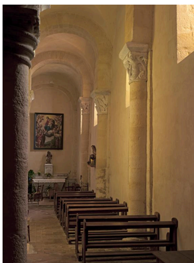
Bas-côté sud en direction de l'est. Phot. Jean-Michel Périn IVR83_20116301429NUC4A
