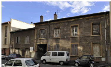
Façade antérieure Phot. Julien Defillon IVR82_20106900928NUCA
