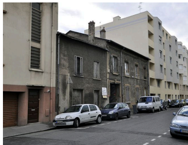
Vue générale Phot. Julien Defillon IVR82_20106900923NUCA
