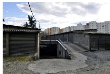
Vue extérieure; arrière de la parcelle, garages. Phot. Julien Defillon IVR82_20106900927NUCA
