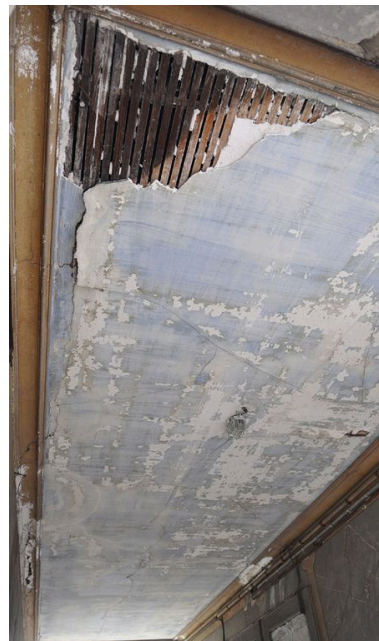
Plafond de l'allée Phot. Julien Defillon IVR82_20106900924NUCA
