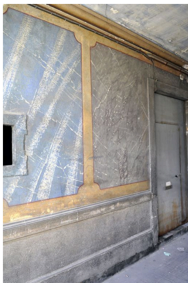
Mur de l'allée Phot. Julien Defillon IVR82_20106900926NUCA
