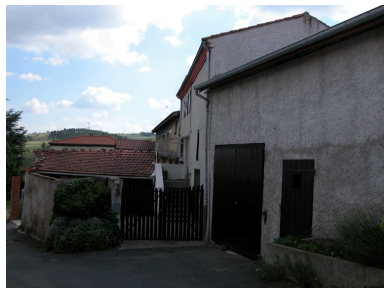
Vue générale. Phot. Thierry Monnet IVR82_20124200290NUCA
