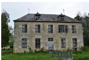
Vue de la façade sud-est du château. Phot. Maryse Durin-Tercelin IVR84_20250300535NUCA
