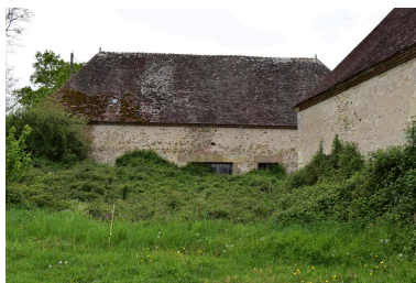
Grange sud-ouest du château de Beaugard Phot. Maryse Durin-Tercelin IVR84_20250300532NUCA
