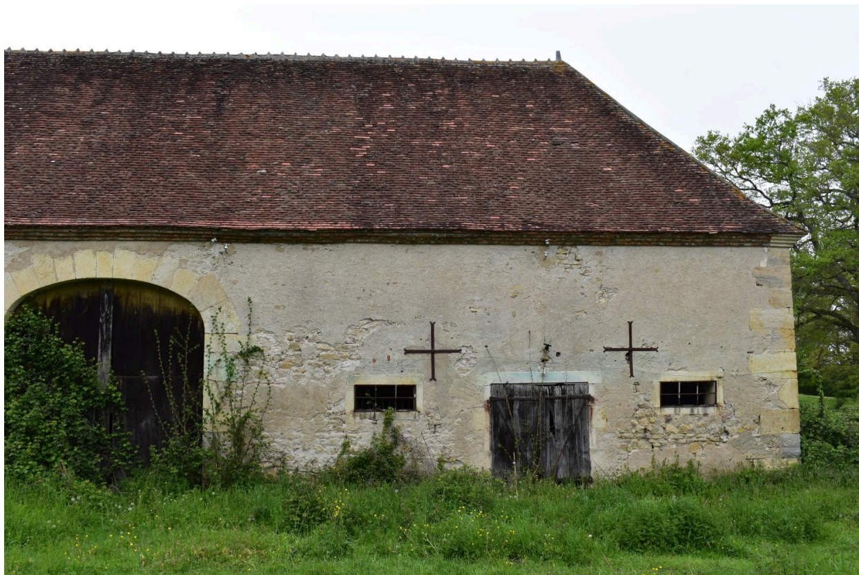
Grange nord-ouest du château de Beauregard
