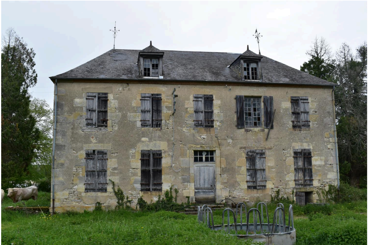
Vue de la façade sud-est du château.
