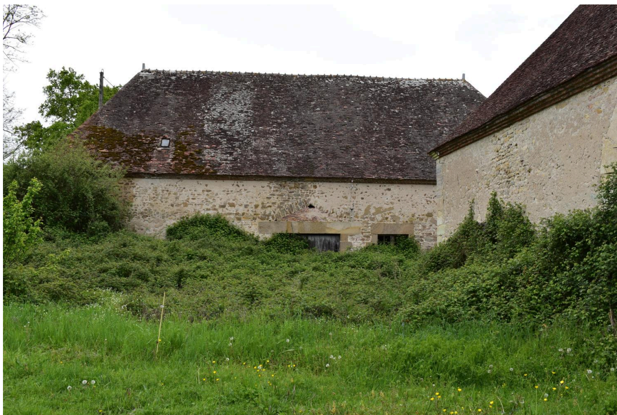
Grange sud-ouest du château de Beauregard
