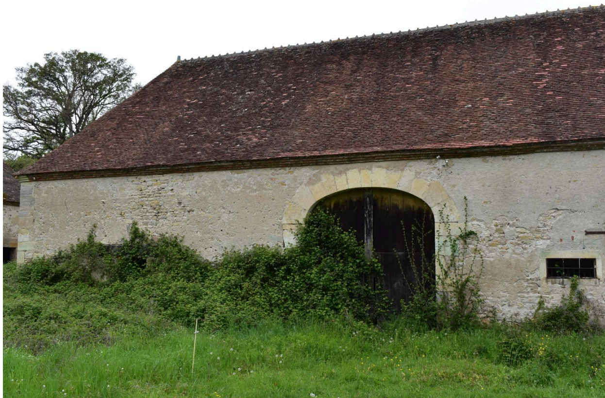
Grange nord-ouest du château de Beauregard
