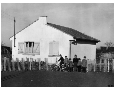
Maison individuelle de la cité des Neuf-Soleils. Vue prise vraisemblablement au début des années 1950. IVR84_20236300177NUC
