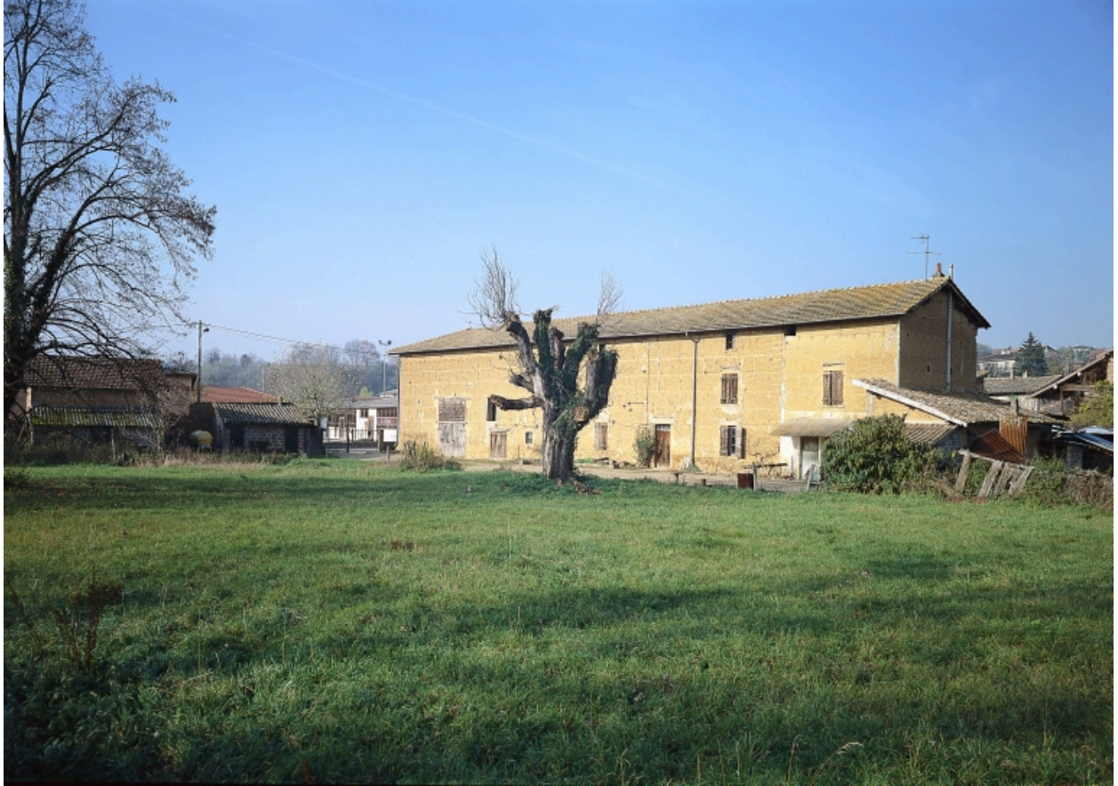
Vue d'ensemble, élévation antérieure.
