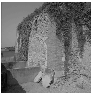
Détail : arc muré de l'ancienne chapelle. Phot. Jean-Marie Refflé IVR82_19920100637X
