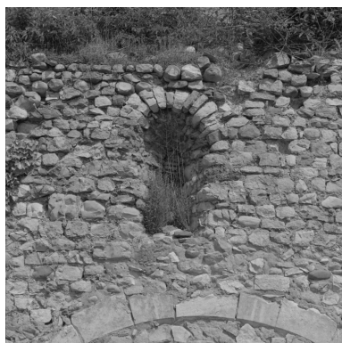
Détail : baie en plein cintre murée.
