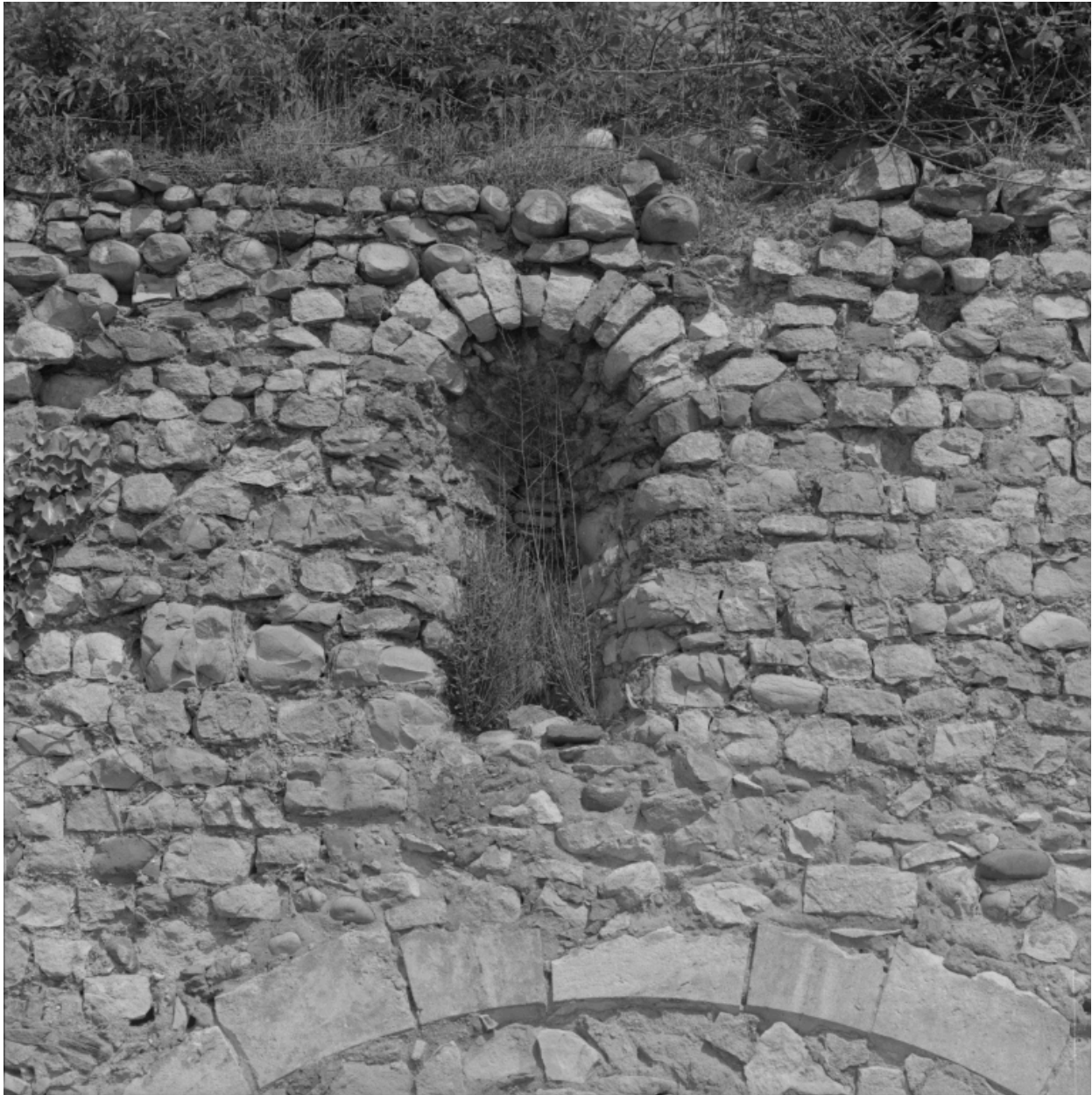
Détail : baie en plein cintre murée.
