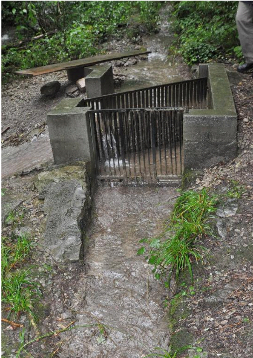
Prise d'eau du ruisseau du Gargot.
