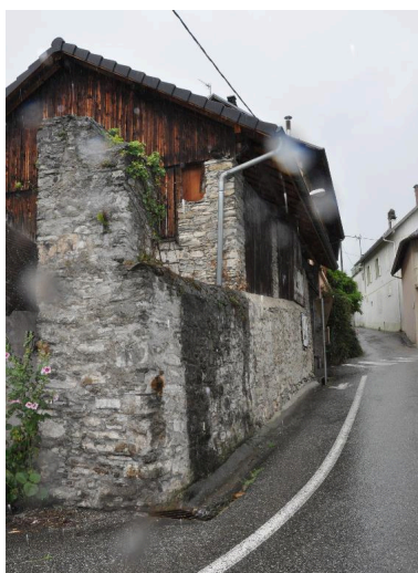
Au premier plan, pilier de pierre qui supportait la conduite d'amenée du site. Phot. Clara Bérelle IVR82_20157301596NUCA
