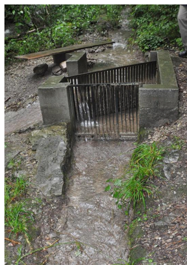
Prise d'eau du ruisseau du Gargot. Phot. Clara Bérelle IVR82_20157301597NUCA
