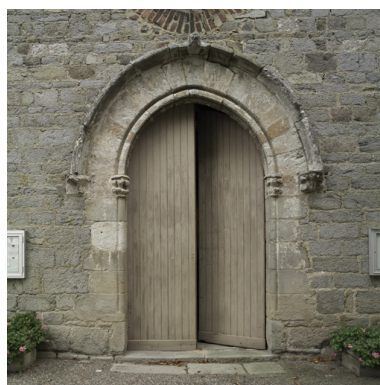
Vue du portail occidental. Phot. Eric Dessert IVR82_20064202128NUCA
