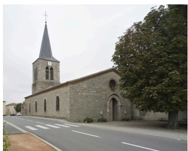
Vue d'ensemble de trois-quarts nord-ouest.
