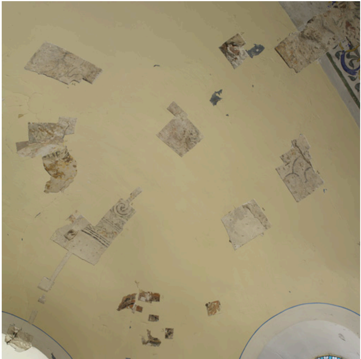
Vue des fenêtres de sondage des peintures murales de l'abside.
