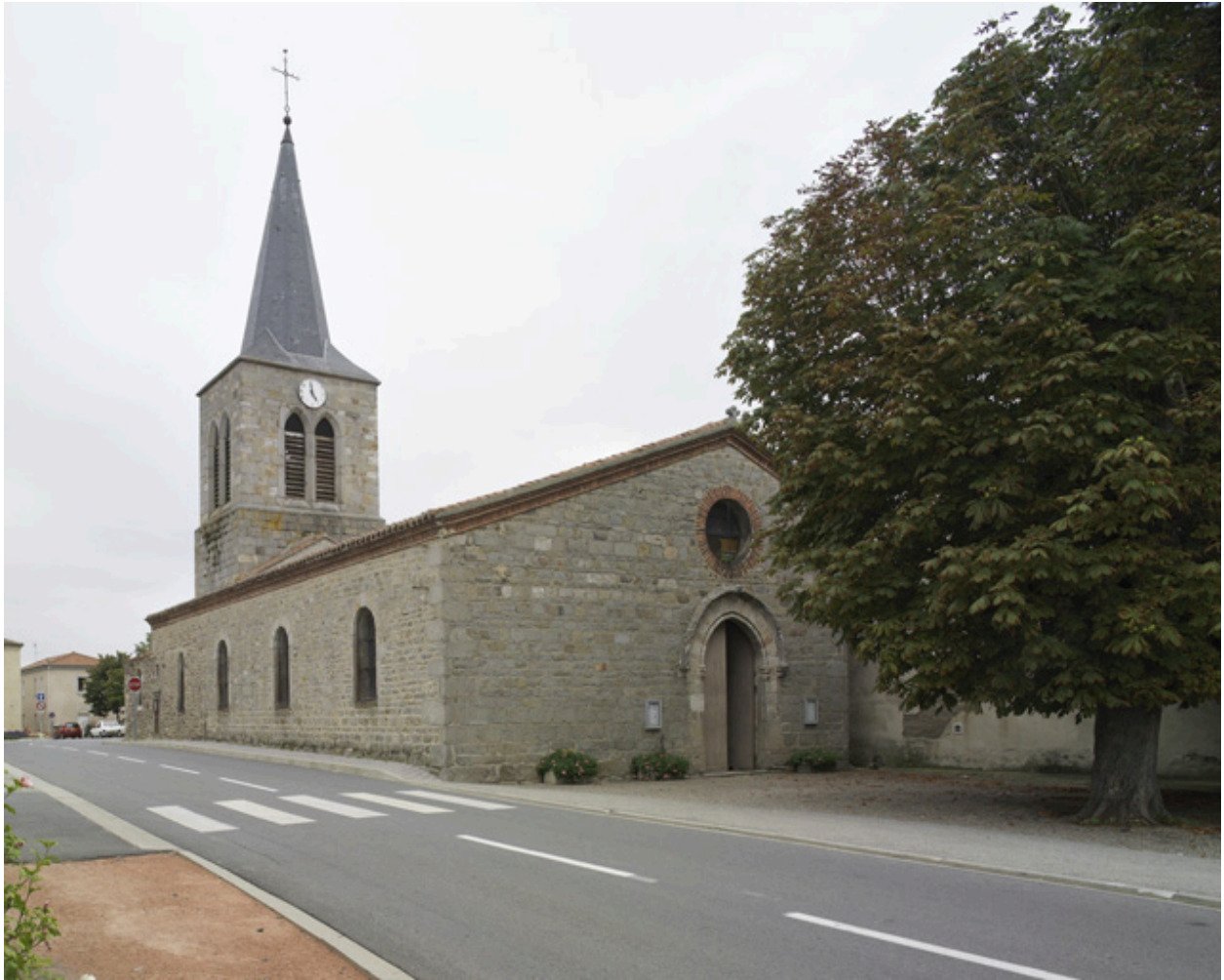
Vue d'ensemble de trois-quarts nord-ouest.
