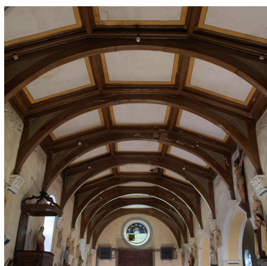
Vue du lambris de couverture de la nef, depuis l'est.
