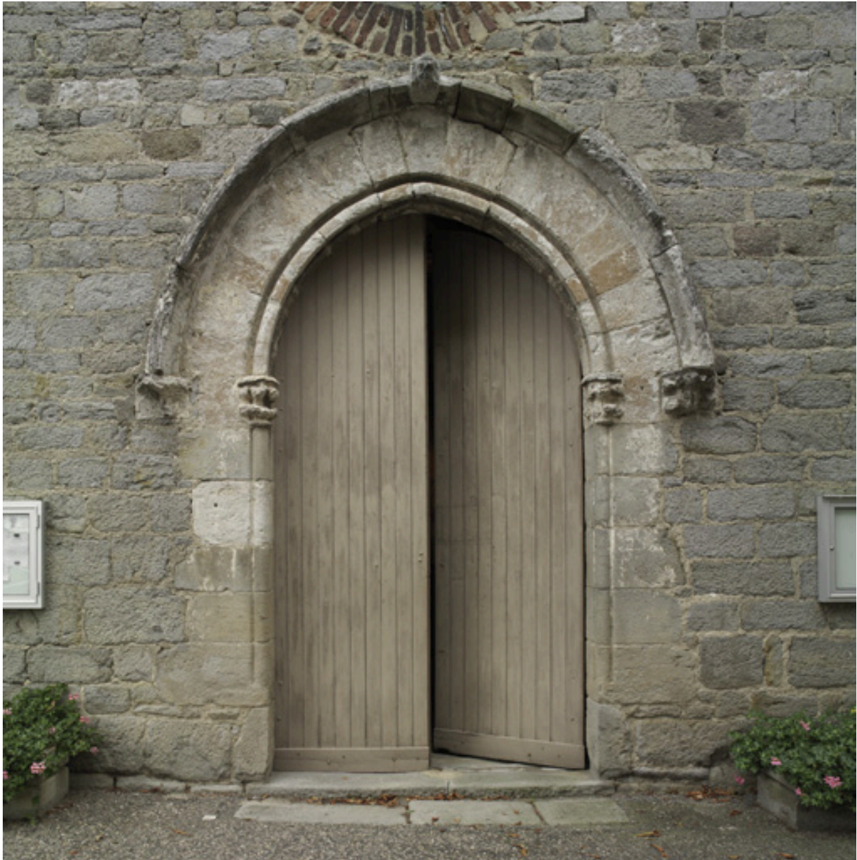
Vue du portail occidental.
