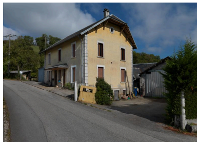
Vue d'ensemble de la fruitière de trois-quarts avant droit. Phot. Thierry Leroy IVR84_20167401896NUCAQ
