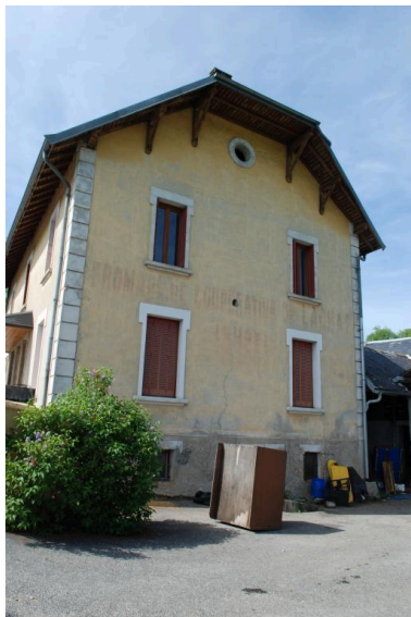
Vue d'ensemble du mur pignon sud. Phot. Thierry Monnet IVR84_20187400413NUCA
