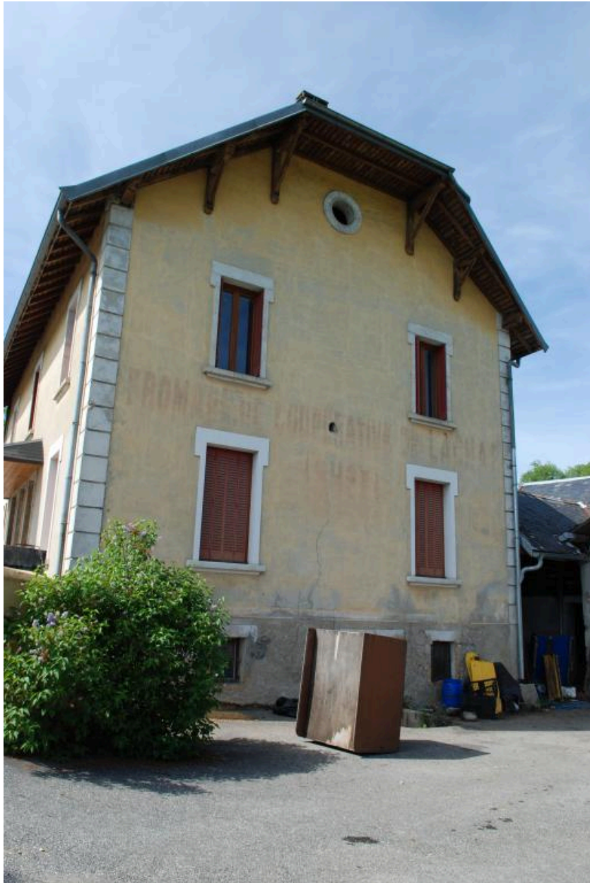
Vue d'ensemble du mur pignon sud.
