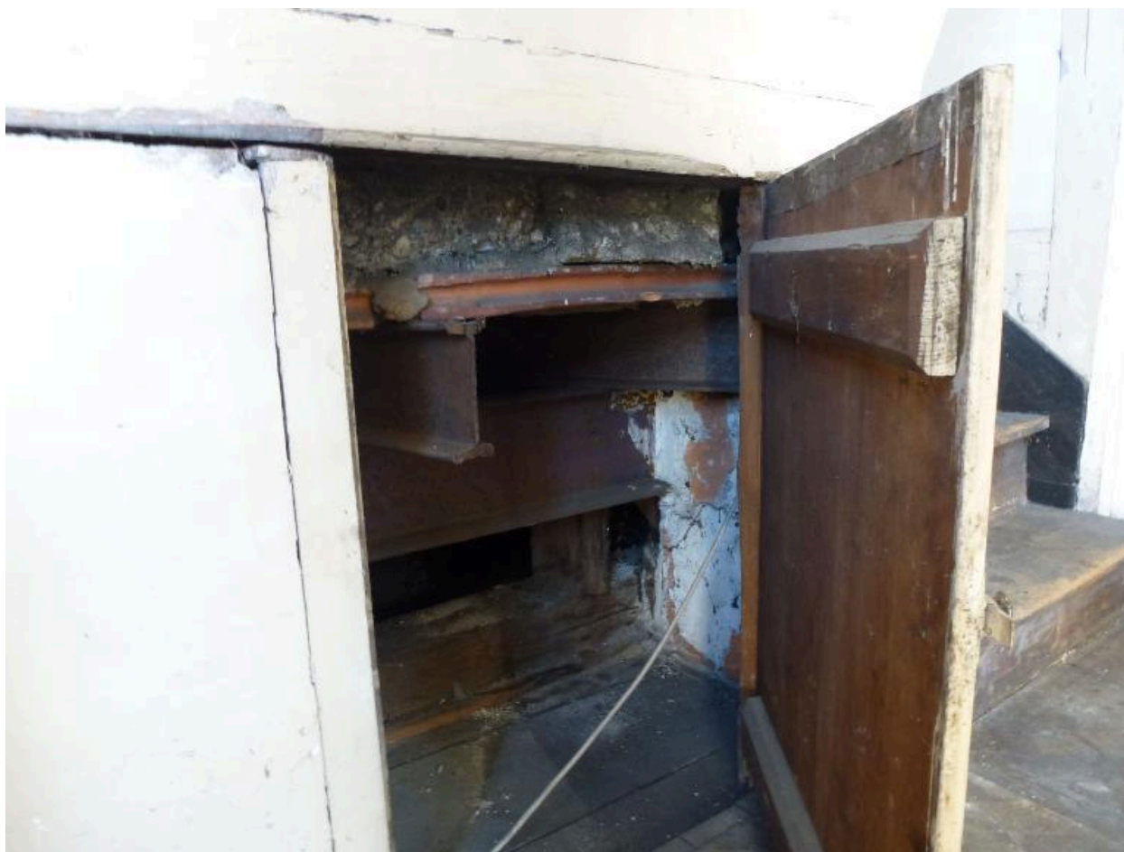
Second étage. Accès à la structure de la base de la flèche conique, constituée d'IPN. (Photo chercheur).
