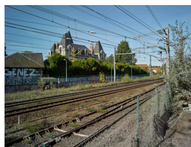
Vue de la villa Languille depuis la cour d'un édifice commercial situé de l'autre côté de la voie ferrée, rue Denis-Papin. Phot. Christian Parisey IVR84_20170300093NUC4A
