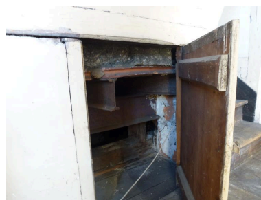
Second étage. Accès à la structure de la base de la flèche conique, constituée d'IPN. (Photo chercheur). Phot. Bénédicte Renaud-Morand IVR84_20170300105NUCA
