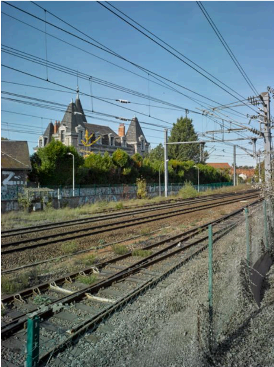
Vue de la villa Languille depuis la cour d'un édifice commercial situé de l'autre côté de la voie ferrée, rue Denis-Papin.
