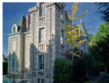
Façade est et élévation latérale sud. La façade est parallèle à la voie ferrée, la rangée de thuyas qu'on aperçoit à droite du cliché ont été plantés au XXe siècle de façon à isoler la demeure du trafic ferroviaire. C'est la façade sur laquelle est installé le seul balcon, au premier étage, qui permettait d'apprécier le spectacle du chemin de fer au XIXe siècle. Phot. Christian Parisey IVR84_20170300098NUC4A
