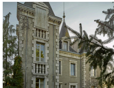
Façade nord, au-dessus de laquelle on aperçoit la flèche conique d'un pavillon dont les bases sont situées à l'étage de comble, à l'ouest. Phot. Christian Parisey IVR84_20170300100NUC4A
