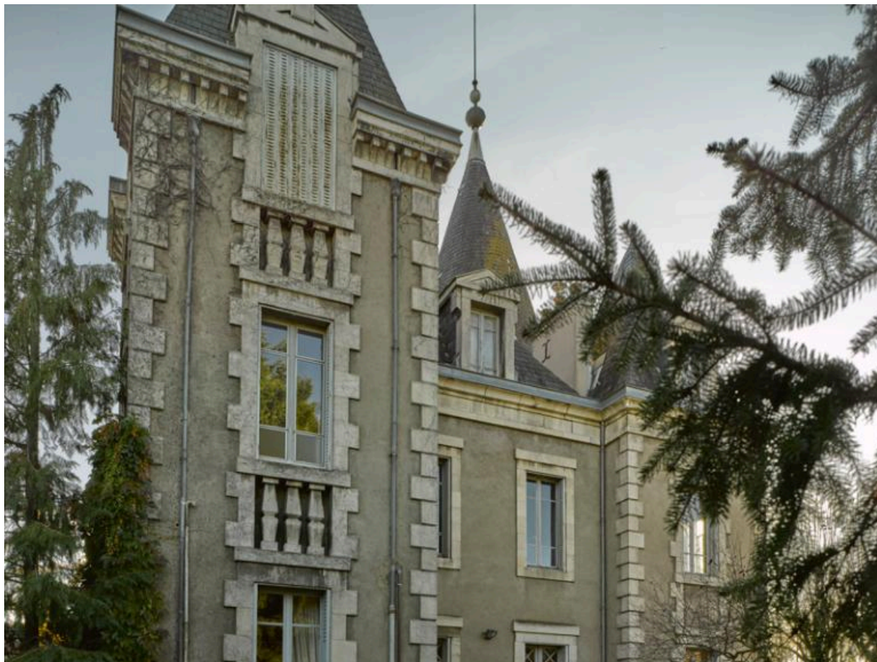
Façade nord, au-dessus de laquelle on aperçoit la flèche conique d'un pavillon dont les bases sont situées à l'étage de comble, à l'ouest.
