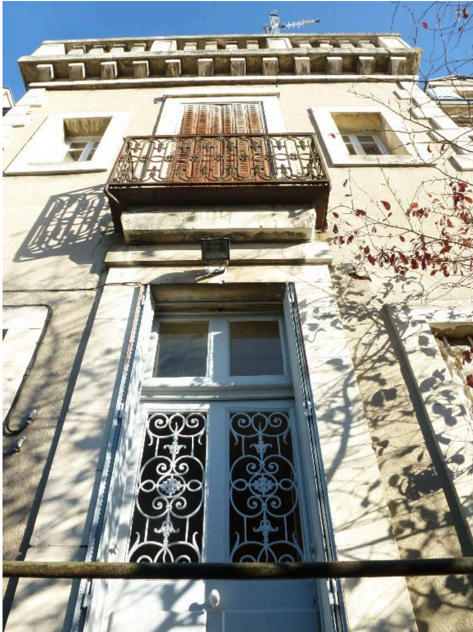
Élévation ouest, avant-corps central. Il s'agit de l'entrée secondaire. (Photo chercheur).
