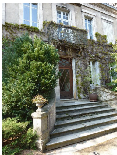
Façade est, façade d'entrée principale, parallèle à la voie ferrée. Le balcon permettait, à l'origine, de jouir du spectacle du chemin de fer et, à l'arrière-plan, des prés qui séparaient les communes de Moulins et d'Yzeure. Les motifs géométriques de la menuiserie de la porte d'entrée sont très tardifs tandis que le décor en fonte du balcon est représentatif des décors du Second Empire. (Photo chercheur). Phot. Bénédicte Renaud-Morand IVR84_20170300104NUCA
