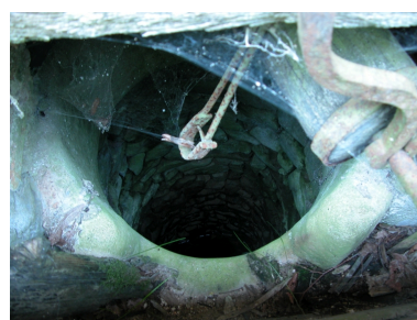
Vue intérieure du puits. Phot. Thierry Monnet IVR82_20134201655NUCA
