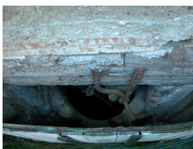
Vue intérieure du puits. Phot. Thierry Monnet IVR82_20134201654NUCA
