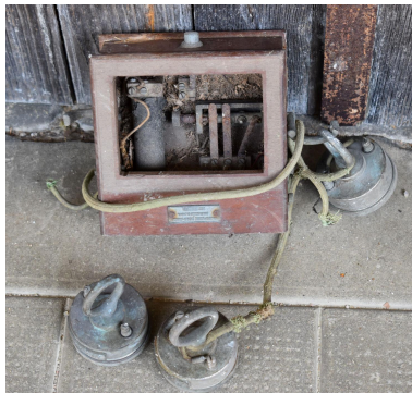
Vue générale - Matériel Mors-Abdank Phot. Maryse Durin-Tercelin IVR84_20226300728NUCA
