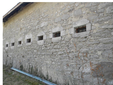
Vue de la façade arrière. Phot. Jérôme Daviet IVR82_20127400885NUCA
