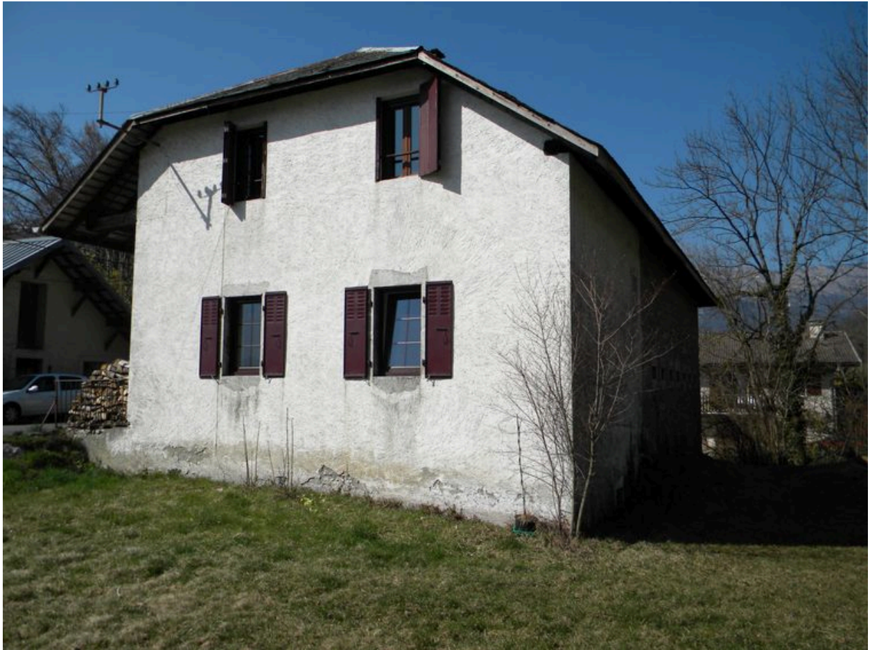
Vue du pignon est.
