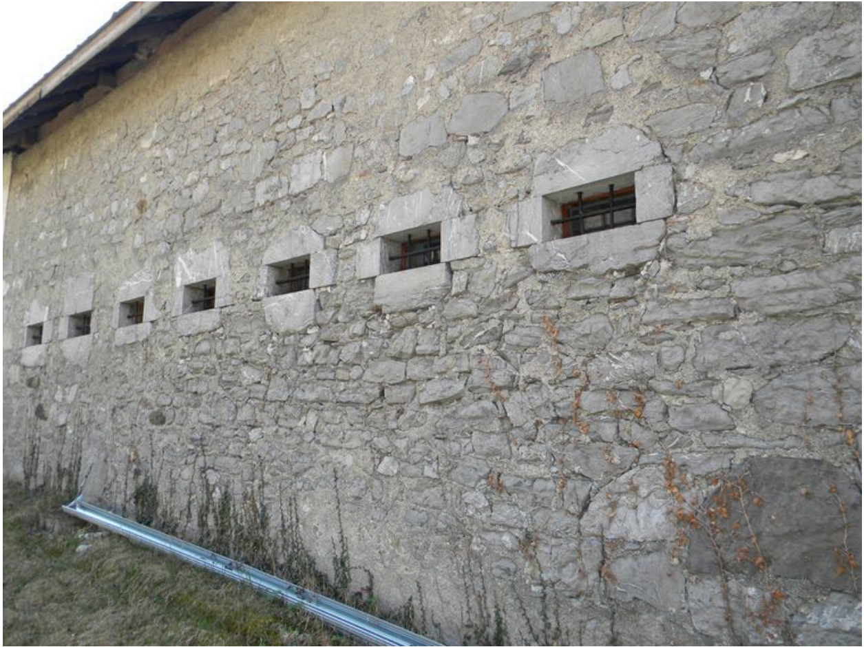
Vue de la façade arrière.
