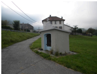
Vue de trois-quarts. Phot. Jérôme Daviet IVR82_20157401717NUCA
