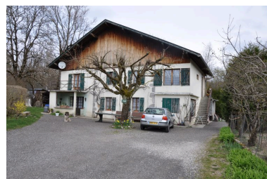
Travées de la façade antérieure du bâtiment du moulin entièrement remaniée Phot. Samir Mahfoudi, Autr. Samir Mahfoudi IVR82_20107400175NUCA
