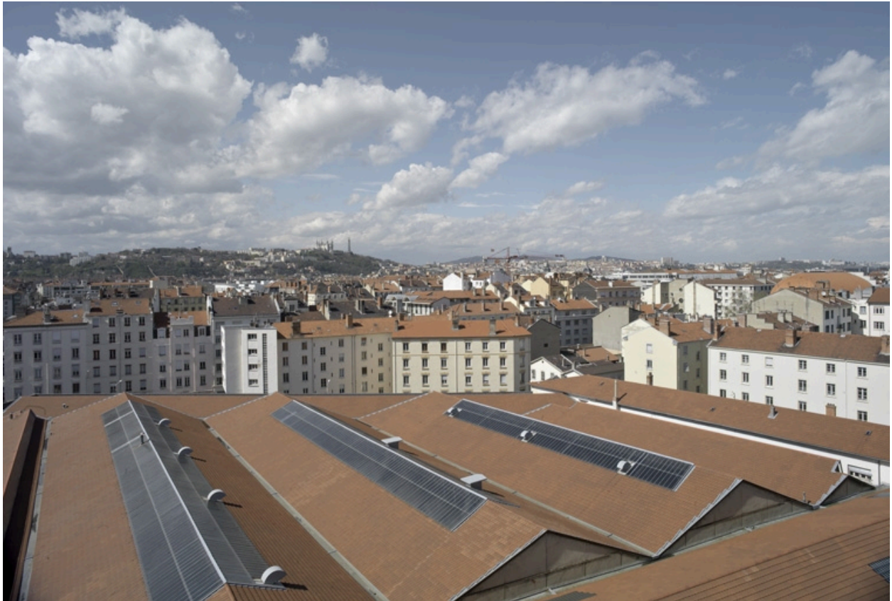
Toiture, vue sud-est
