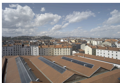
Toiture, vue sud-est Phot. Eric Dessert IVR82_20086901035NUCA
