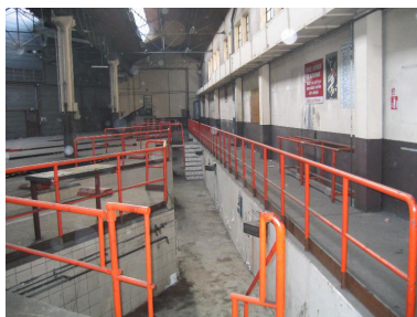
Vue intérieur du dépôt parmentier, vue des fosses d'entretien du matériel roulant Phot. Nadine Halitim-Dubois IVR82_20116900447NUCA
