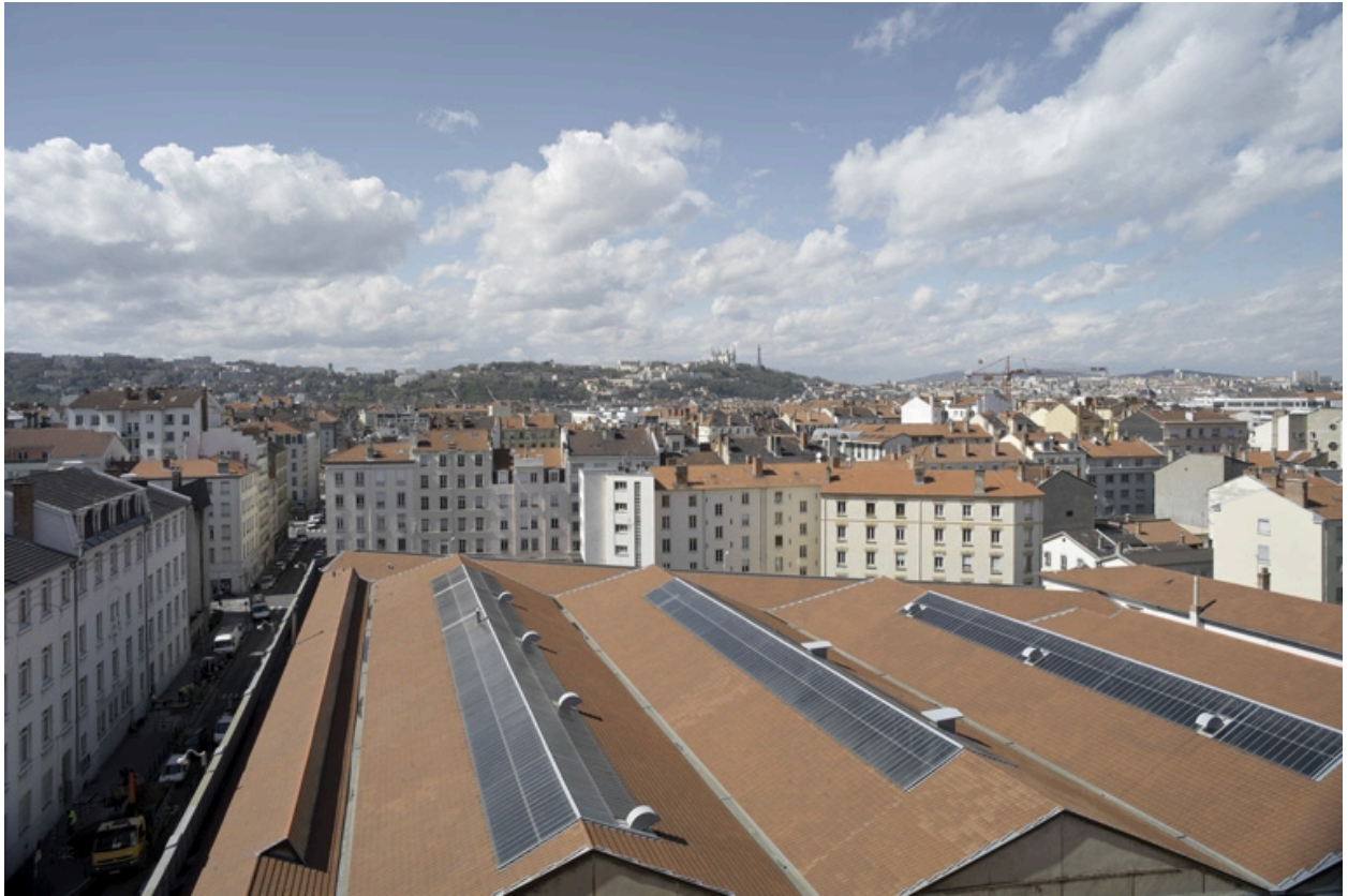
Toiture, vue est, lanterneaux
