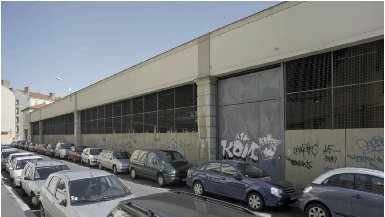
Façade nord-ouest, rue d'Anvers, entrée des véhicules
