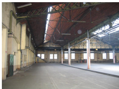
Vue intérieur du dépôt parmentier Phot. Nadine Halitim-Dubois IVR82_20116900452NUCA
