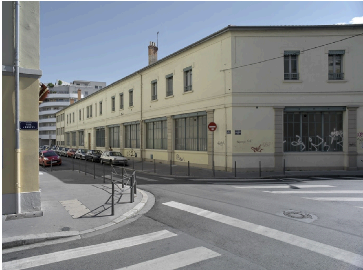
Façade nord, rue Jaboulay, partie administrative au premier étage
