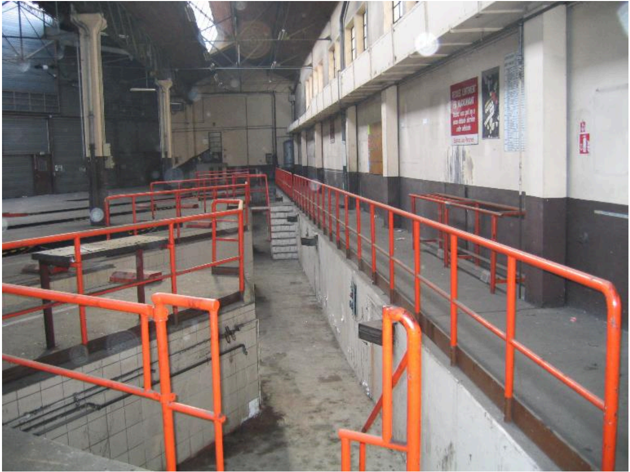
Vue intérieur du dépôt parmentier, vue des fosses d'entretien du matériel roulant
