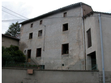
Vue générale Phot. Thierry Monnet IVR82_20124200603NUCA
