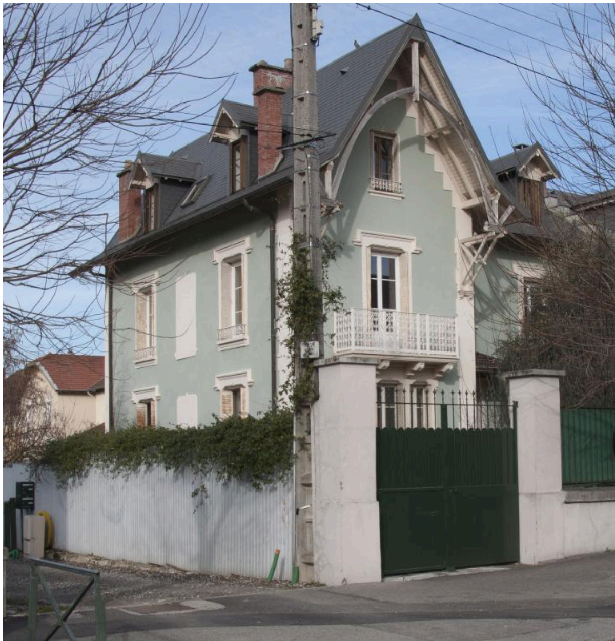
Façades ouest et principale
