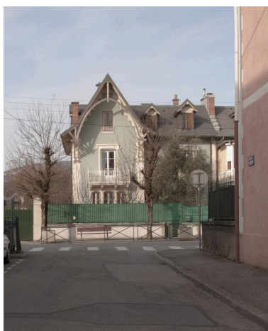
Vue d'ensemble Phot. Denys Harreau IVR84_20177300318NUCA
