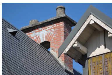
Souche de cheminée Phot. François Fouger IVR82_20117300213NUCA
