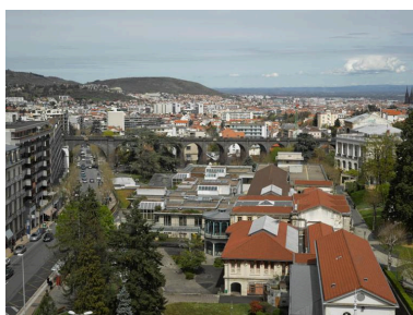
Vue générale du viaduc dit de Royat : à gauche, l'arche plus large passant au-dessus de l'avenue qui sert de promenade « aux habitants de Clermont et aux baigneurs et touristes de Royat » Phot. Jean-Michel Périn IVR84_20166300112NUC4A
