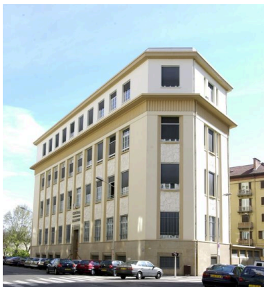
Elévations ouest et sud Phot. Bernard Ducouret IVR82_20046902087NUCA
