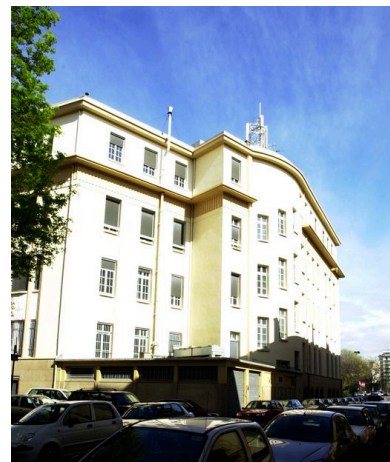
Elévation est Phot. David Chevallier IVR82_20046902089NUCA
