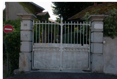
Portail d'entrée Phot. Denys Harreau IVR82_20137300837NUCA
