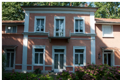
Façade sur jardin, détail du corps principal Phot. Denys Harreau IVR82_20137300842NUCA
