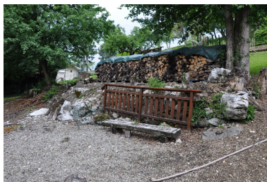
Vue d'une partie des pierres de soubassement du moulin Phot. Yannick Milleret IVR82_20127301543NUCA
