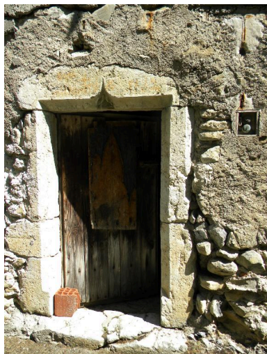
Porte à accolade sur le pignon sud. Phot. Jérôme Daviet IVR82_20137401884NUCA
