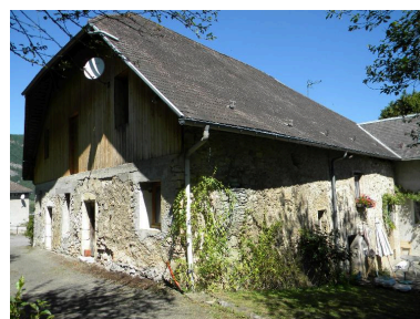
Vue de trois quarts. Phot. Jérôme Daviet IVR82_20137401883NUCA
