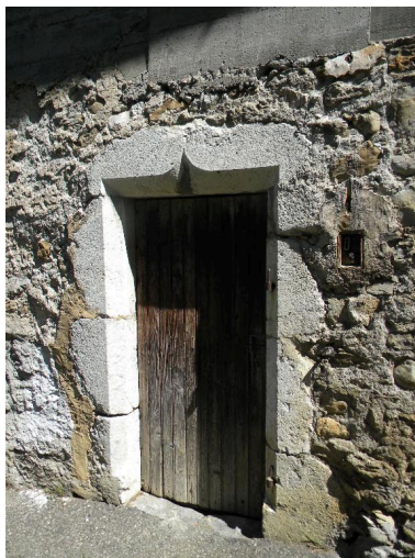
Seconde porte à accolade sur le pignon sud. Phot. Jérôme Daviet IVR82_20137401888NUCA
