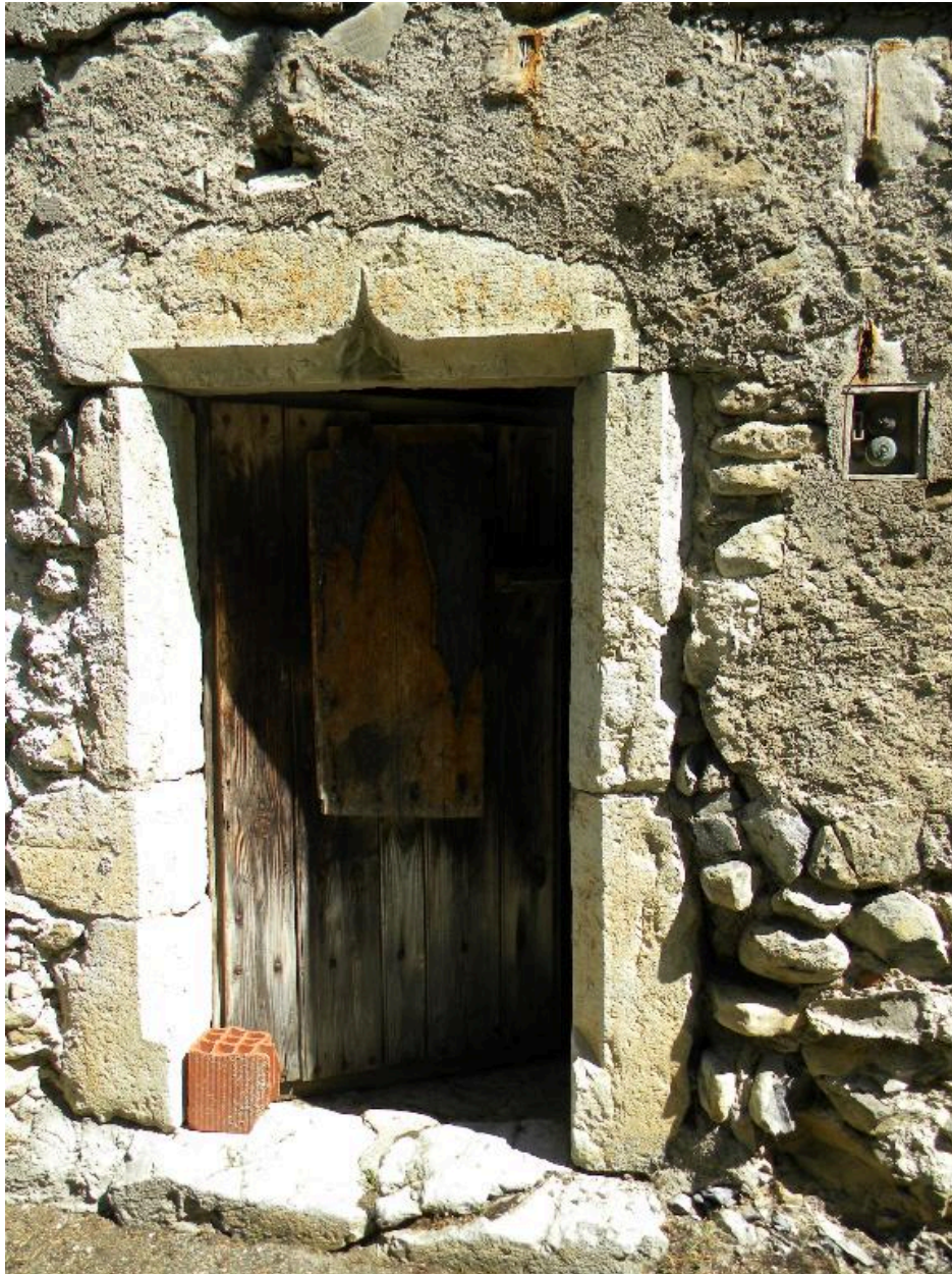
Porte à accolade sur le pignon sud.
