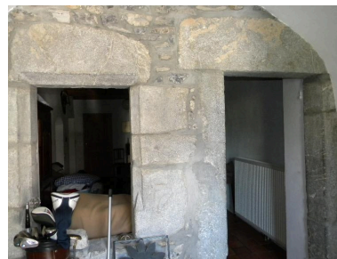
Anciens encadrements de porte et fenêtre de logis en partie intérieur du bâtiment. Phot. Jérôme Daviet IVR82_20137401885NUCA
