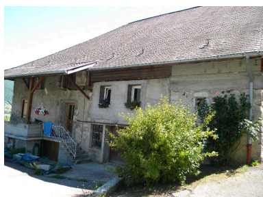
Vue d'ensemble Phot. Jérôme Daviet IVR82_20137401881NUCA
