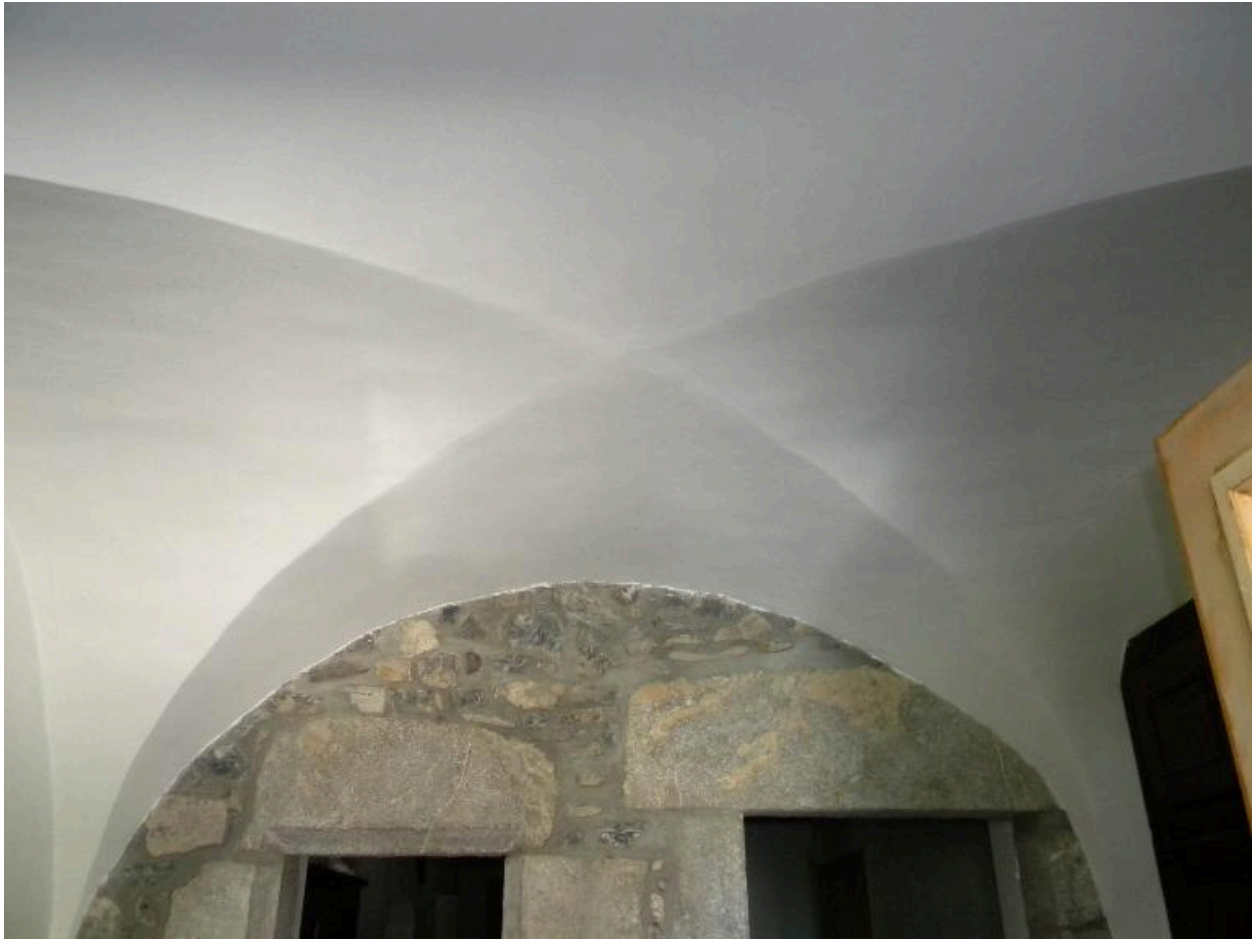
Pièce voûtée d'arrête à l'entrée de la maison.
