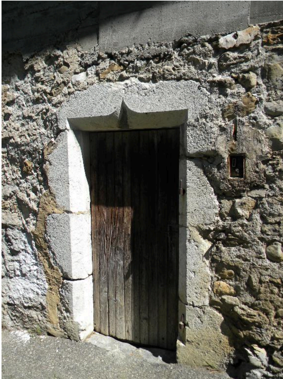
Seconde porte à accolade sur le pignon sud.
