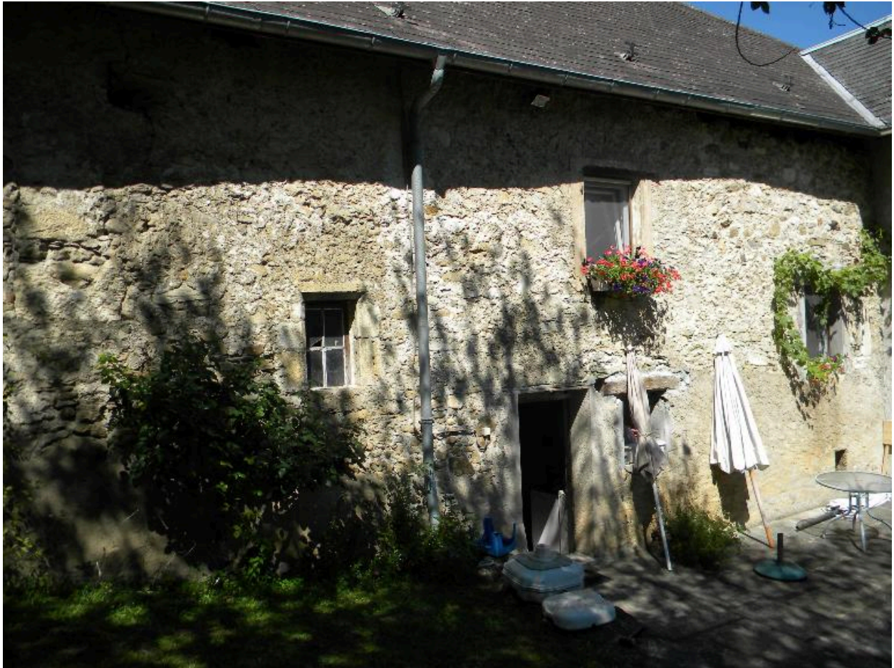
Vue de la façade arrière.
