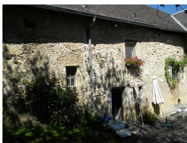
Vue de la façade arrière. Phot. Jérôme Daviet IVR82_20137401882NUCA
