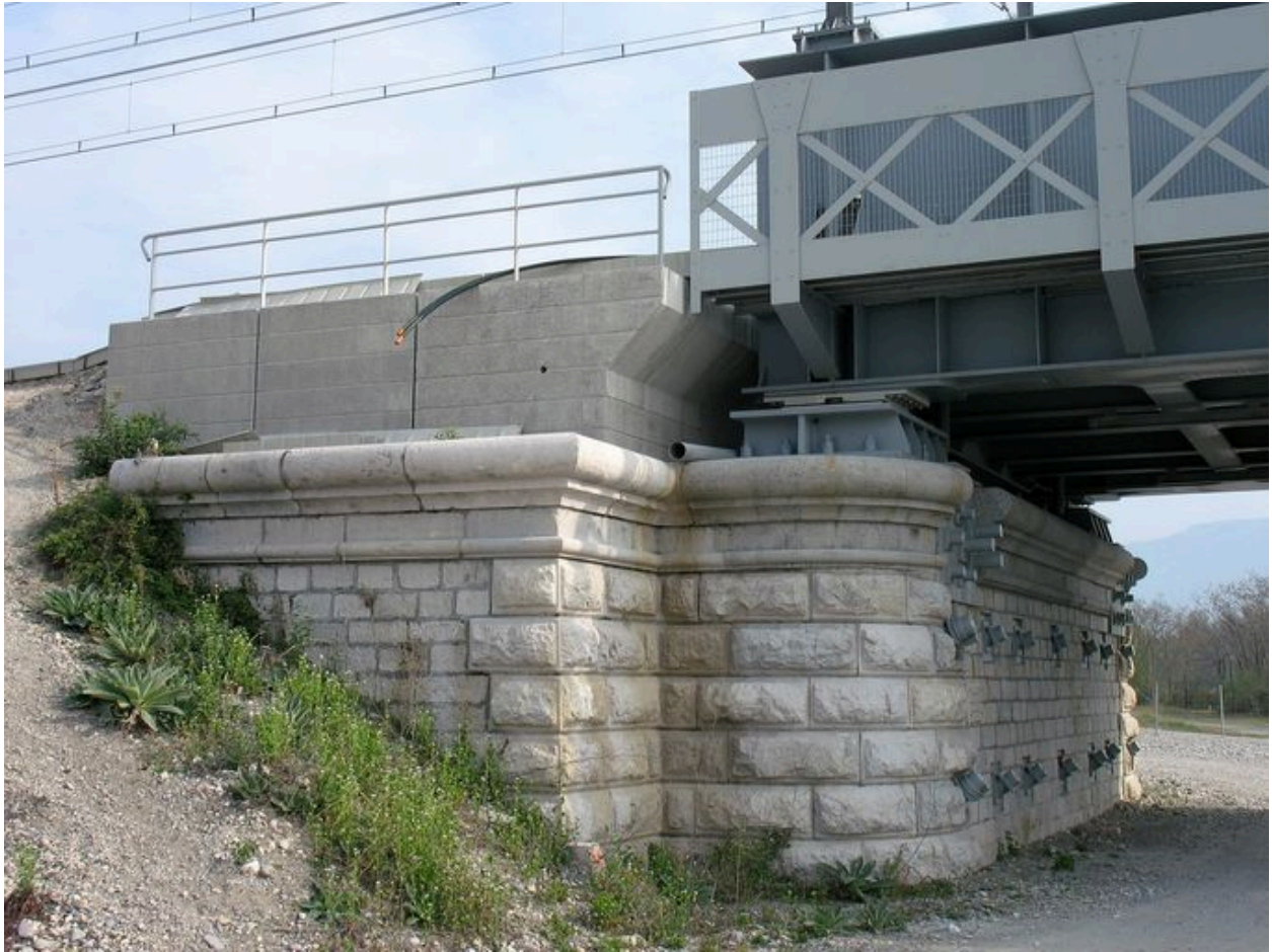
Vue de la culée rive droite, conservée dans l'ouvrage actuel
