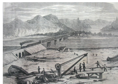
[Pont de Culoz sur le Rhône et chemin de fer] / Anonyme, 1858. 1 est. (lith.) : en noir (MdFR. Collection Dürrenmatt, CP DUR 697) Phot. Maison du Fleuve Rhône, Autr. auteur inconnu 1_ IVR82_20090100058NUCA
