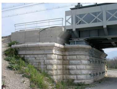
Vue de la culée rive droite, conservée dans l'ouvrage actuel Phot. I. Havard IVR82_20090100020NUCA
