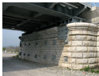
Vue de la culée rive droite (vue partielle), conservée dans l'ouvrage actuel Phot. I. Havard IVR82_20090100021NUCA
