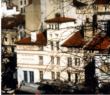
Façade principale Phot. Cendrine Sanquer IVR82_19974202053ZE
