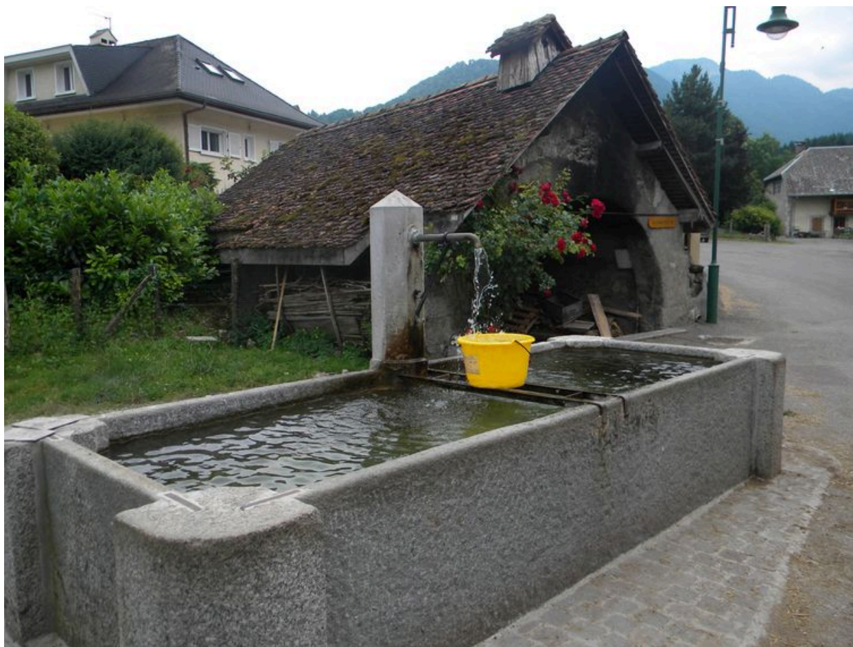
Vue rapprochée du bassin.
