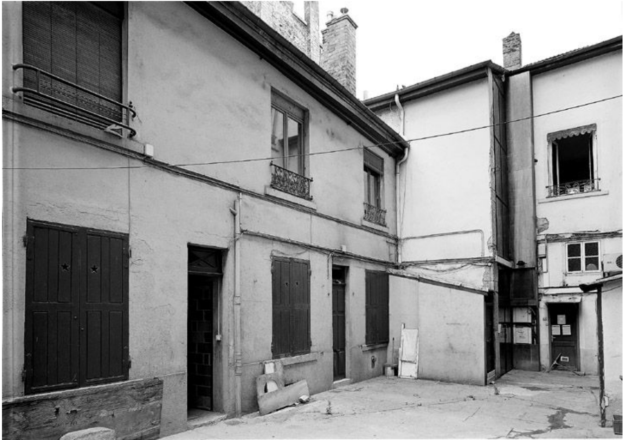
Vue d'ensemble de la cour depuis le sud
