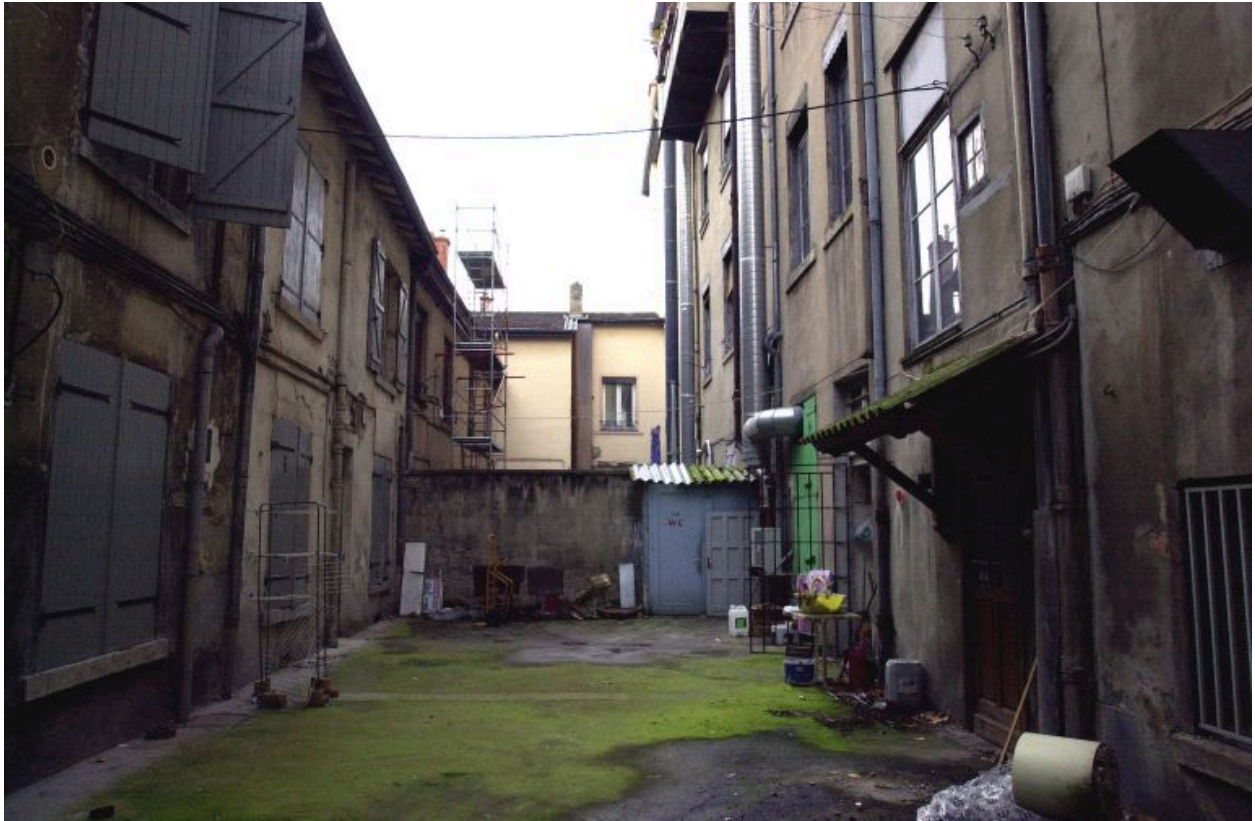
Vue d'ensemble de la cour depuis le sud
