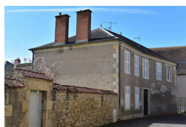
Vue générale du nord-est. Phot. Maryse Durin-Tercelin IVR84_20250300686NUCA
