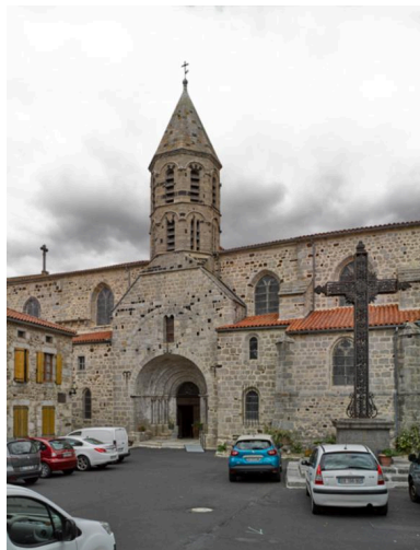
Vue de la façade sud Phot. Christian Parisey IVR84_20174300094NUC4A
