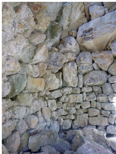
Parement du mur, et départ de l'encorbellement de la coupole.
