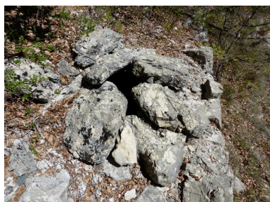
Couverture constituée de l'extrados de la coupole. Phot. Alexeï Laurent IVR84_20162601140NUCA
