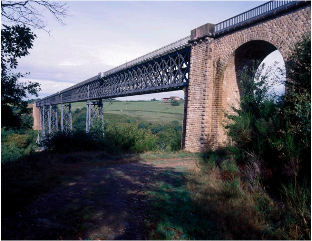
Vue rapprochée du viaduc, de trois quarts, dans le site.
