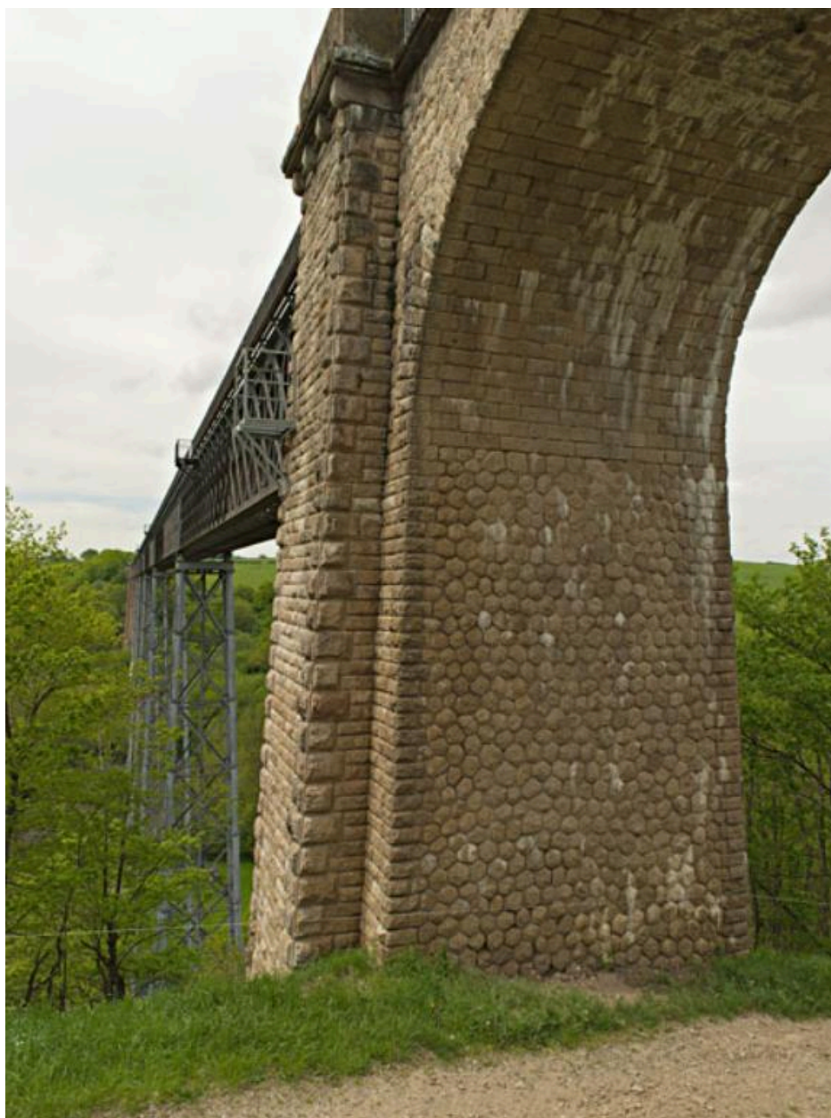
Vue du viaduc en contre-plongée, depuis le pied de l'une des piles en maçonnerie.
