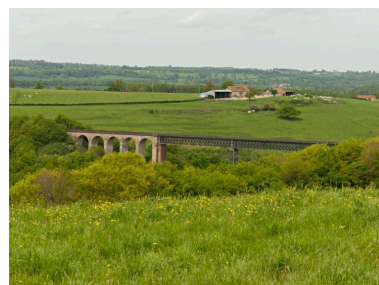
Vue du viaduc de la Bouble dans le site. Phot. Jean-Michel Périn IVR83_20150300046NUC4A
