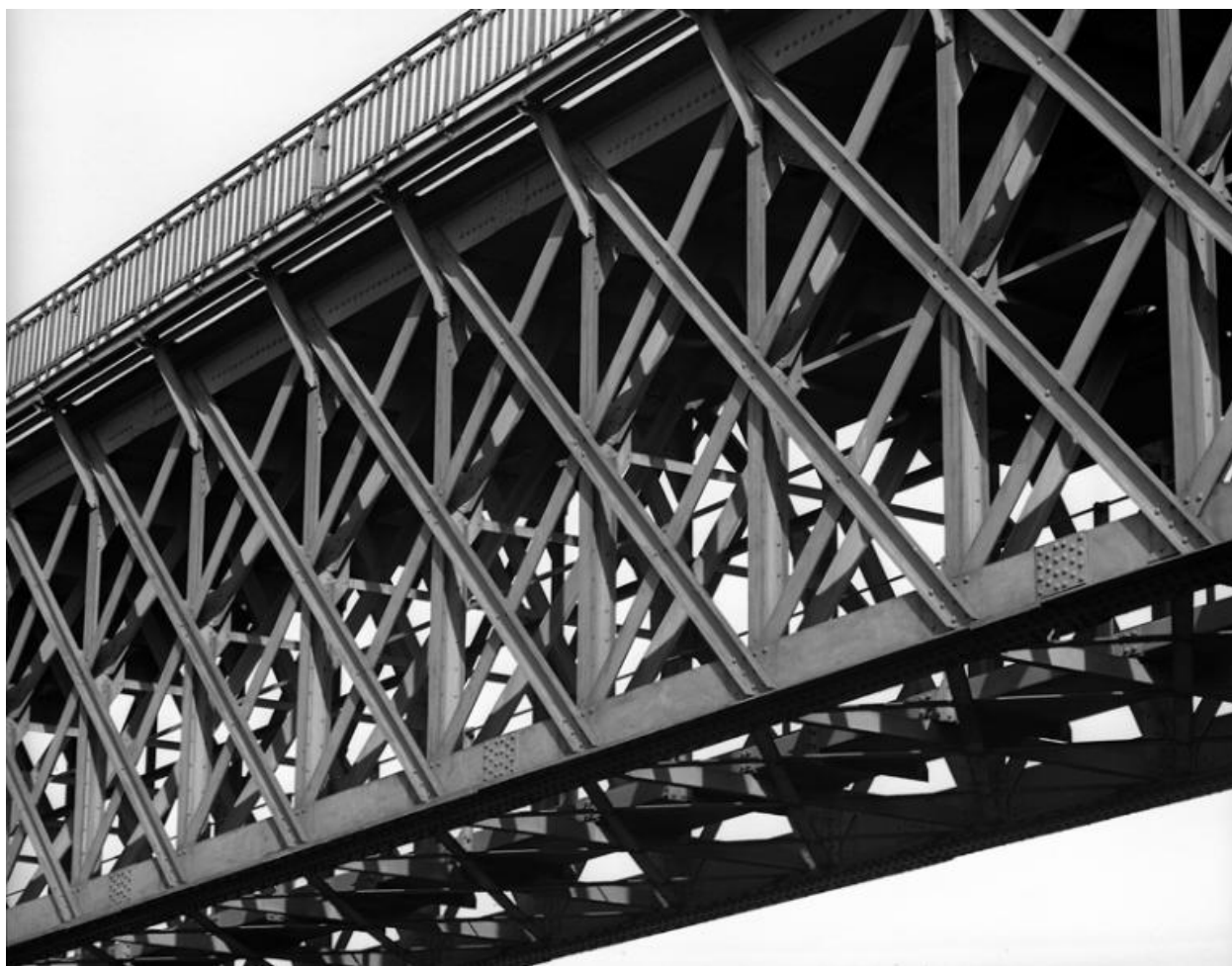
Détail de la structure métallique du tablier.
