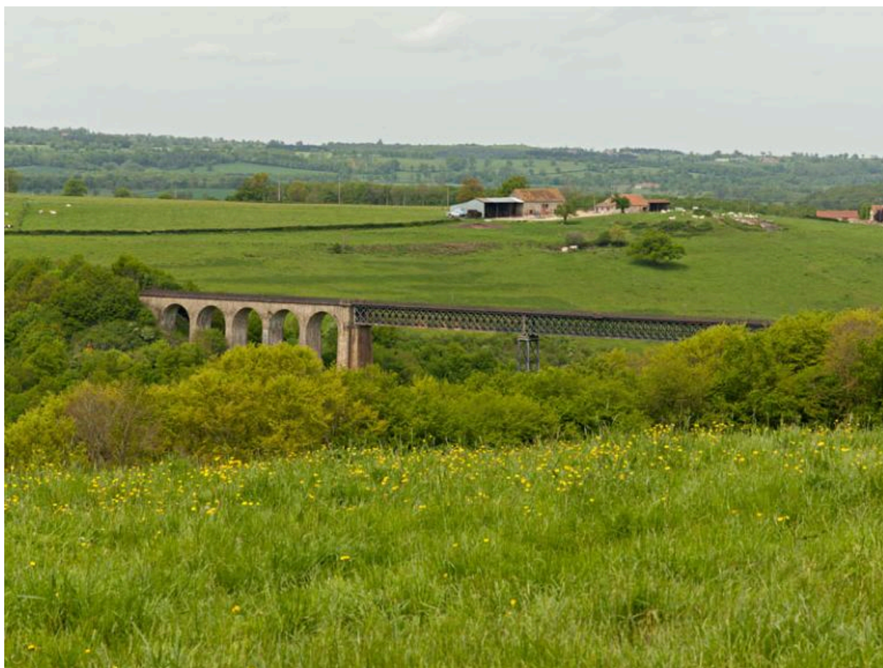
Vue du viaduc de la Bouble dans le site.
