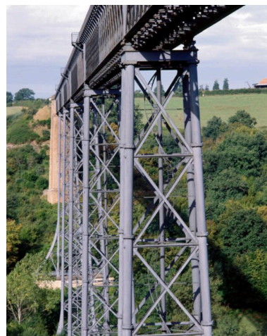
Détail des piles et du tablier métalliques du viaduc. Phot. Roger Choplain, Phot. Roland Maston IVR83_19920300044XA
