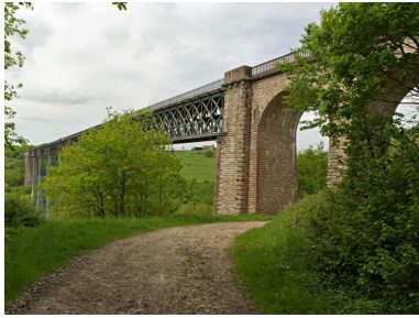
Vue de trois quarts du viaduc depuis le bas. Phot. Jean-Michel Périn IVR83_20150300047NUC4A
