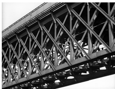
Détail de la structure métallique du tablier. Phot. Roger Choplain, Phot. Roland Maston IVR83_19920300065X
