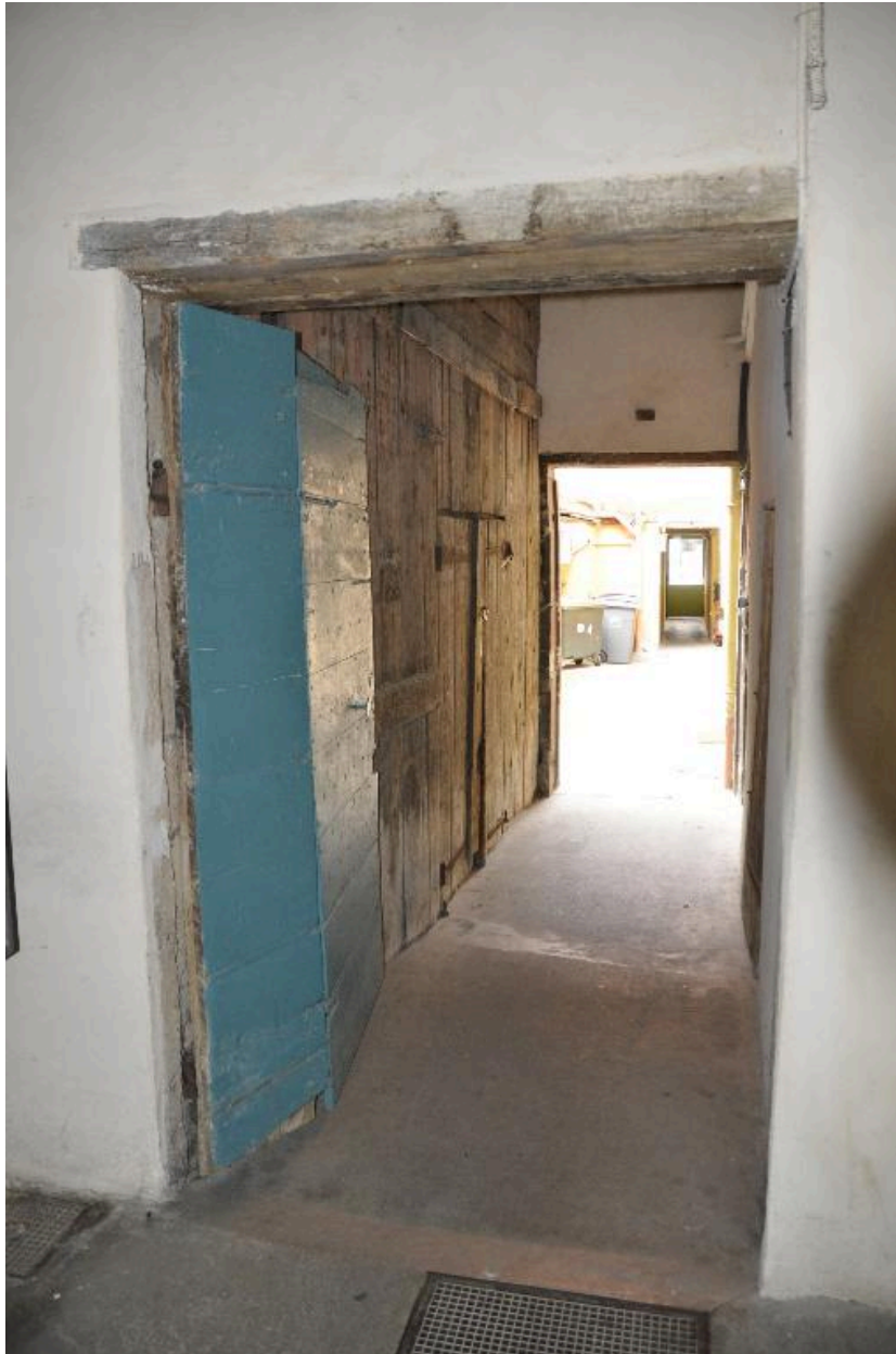
Vue de l'allée de l'immeuble sur cour
