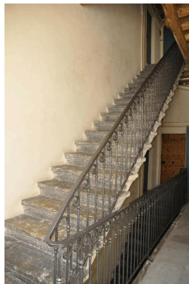
Vue de l'escalier de l'immeuble sur cour Phot. Nadine Halitim-Dubois IVR82_20146900351NUCA
