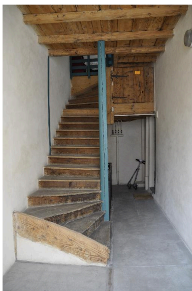
Vue du dernier niveau de l'escalier de l'immeuble sur cour Phot. Nadine Halitim-Dubois IVR82_20146900353NUCA
