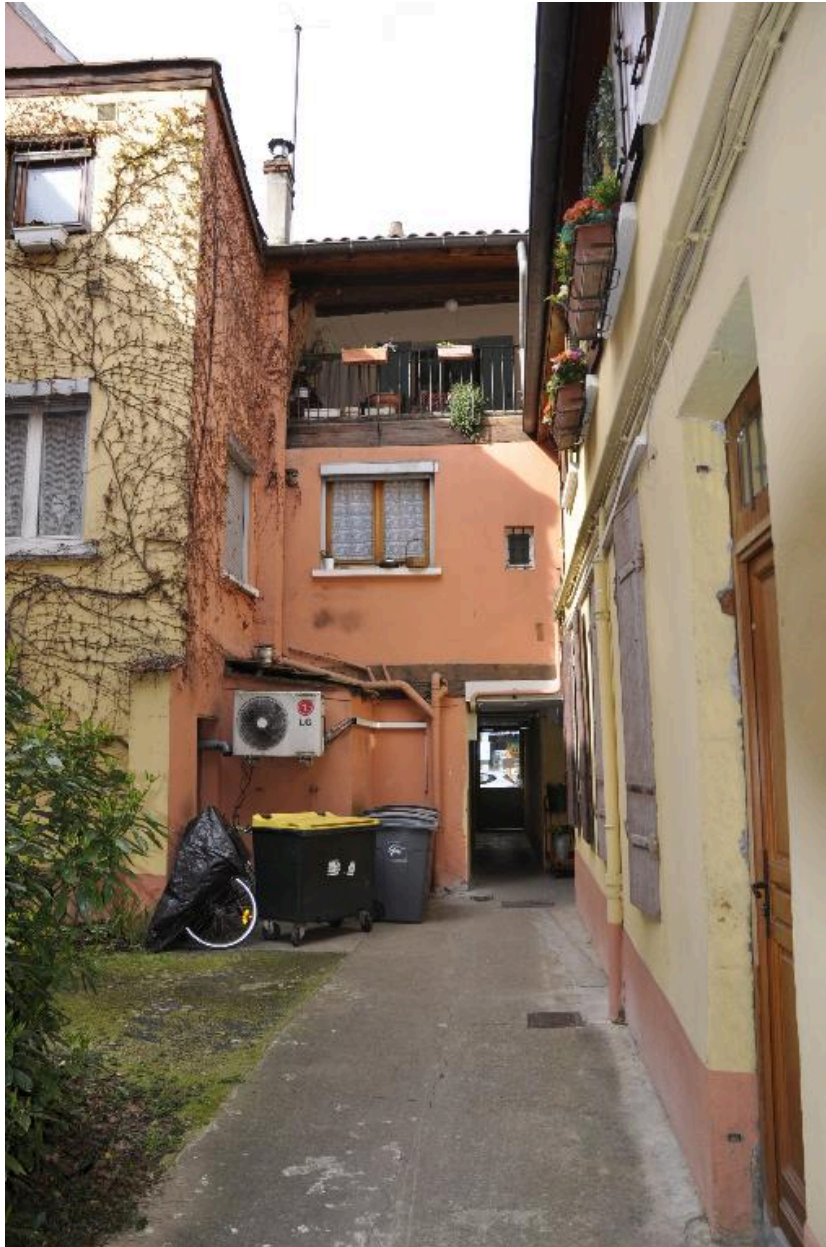
Vue est de l'immeuble sur rue depuis la cour
