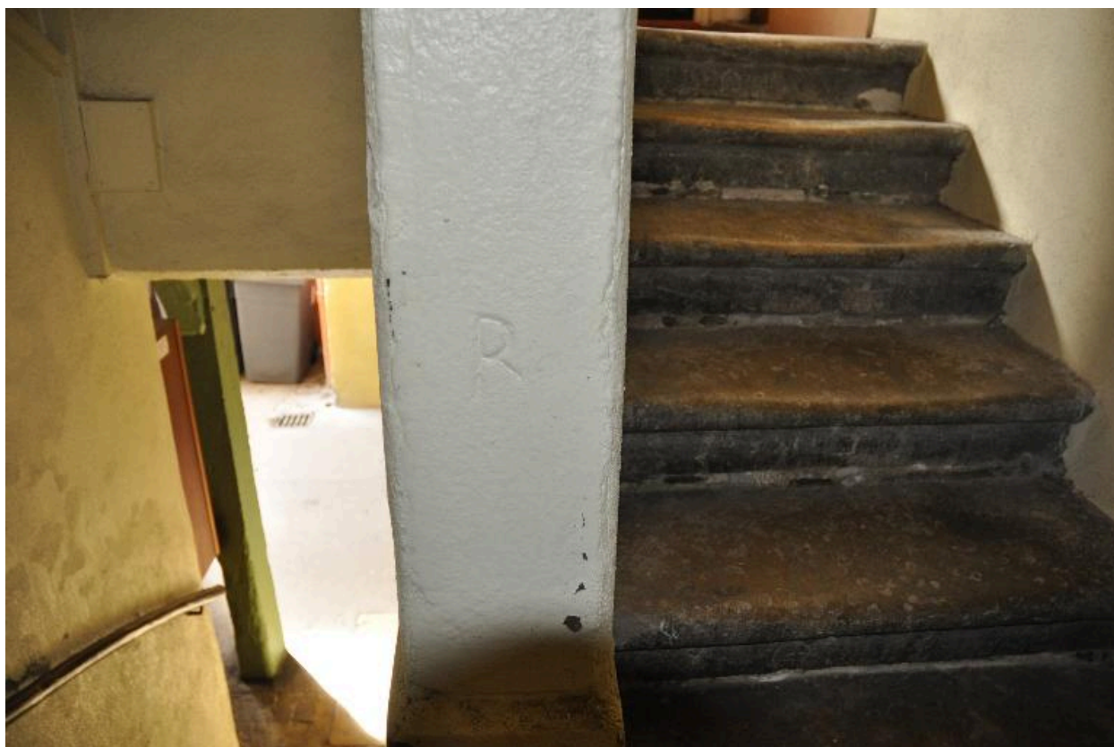
Vue de l'escalier de l'immeuble sur rue
