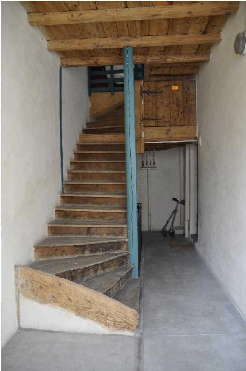
Vue du dernier niveau de l'escalier de l'immeuble sur cour
