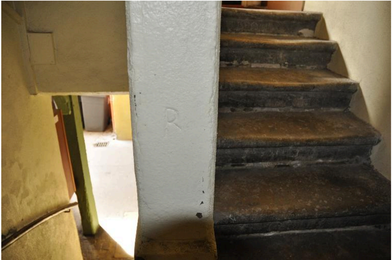
Vue de l'escalier de l'immeuble sur rue
