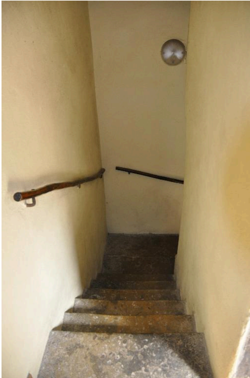
Vue de l'escalier de l'immeuble sur rue depuis le palier
