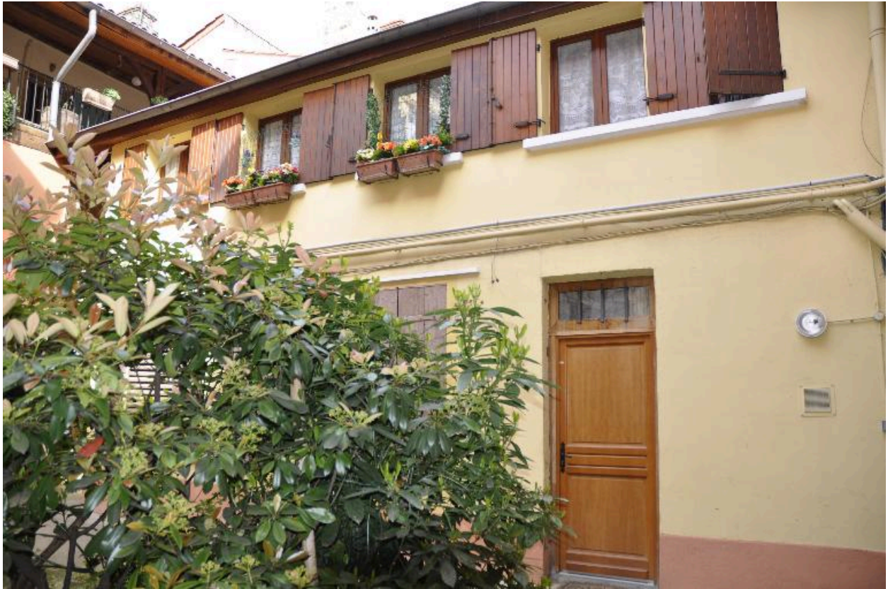
Vue du second corps de bâtiment de l'immeuble sur rue
