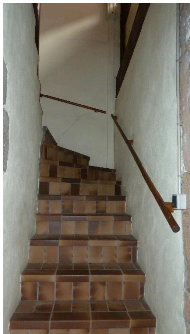
Vue de l'escalier de l'immeuble sur rue depuis le repos Phot. Nadine Halitim-Dubois IVR82_20146900366NUCA
