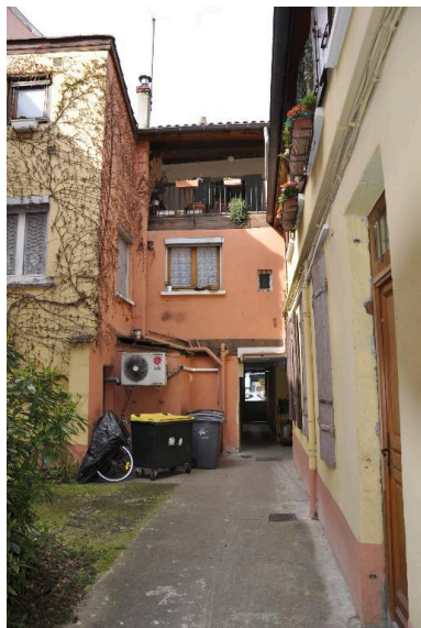
Vue est de l'immeuble sur rue depuis la cour Phot. Nadine Halitim-Dubois IVR82_20146900346NUCA
