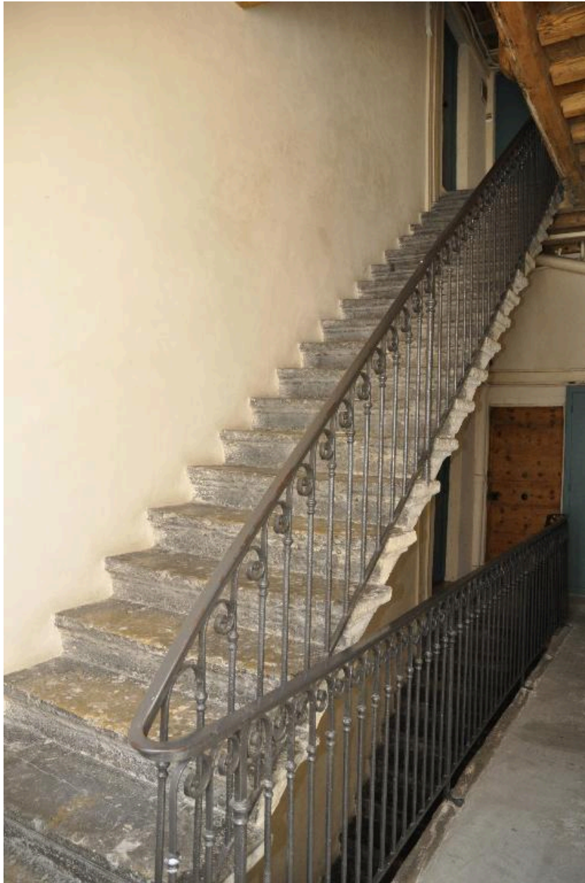
Vue de l'escalier de l'immeuble sur cour
