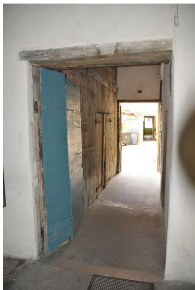
Vue de l'allée de l'immeuble sur cour Phot. Nadine Halitim-Dubois IVR82_20146900349NUCA
