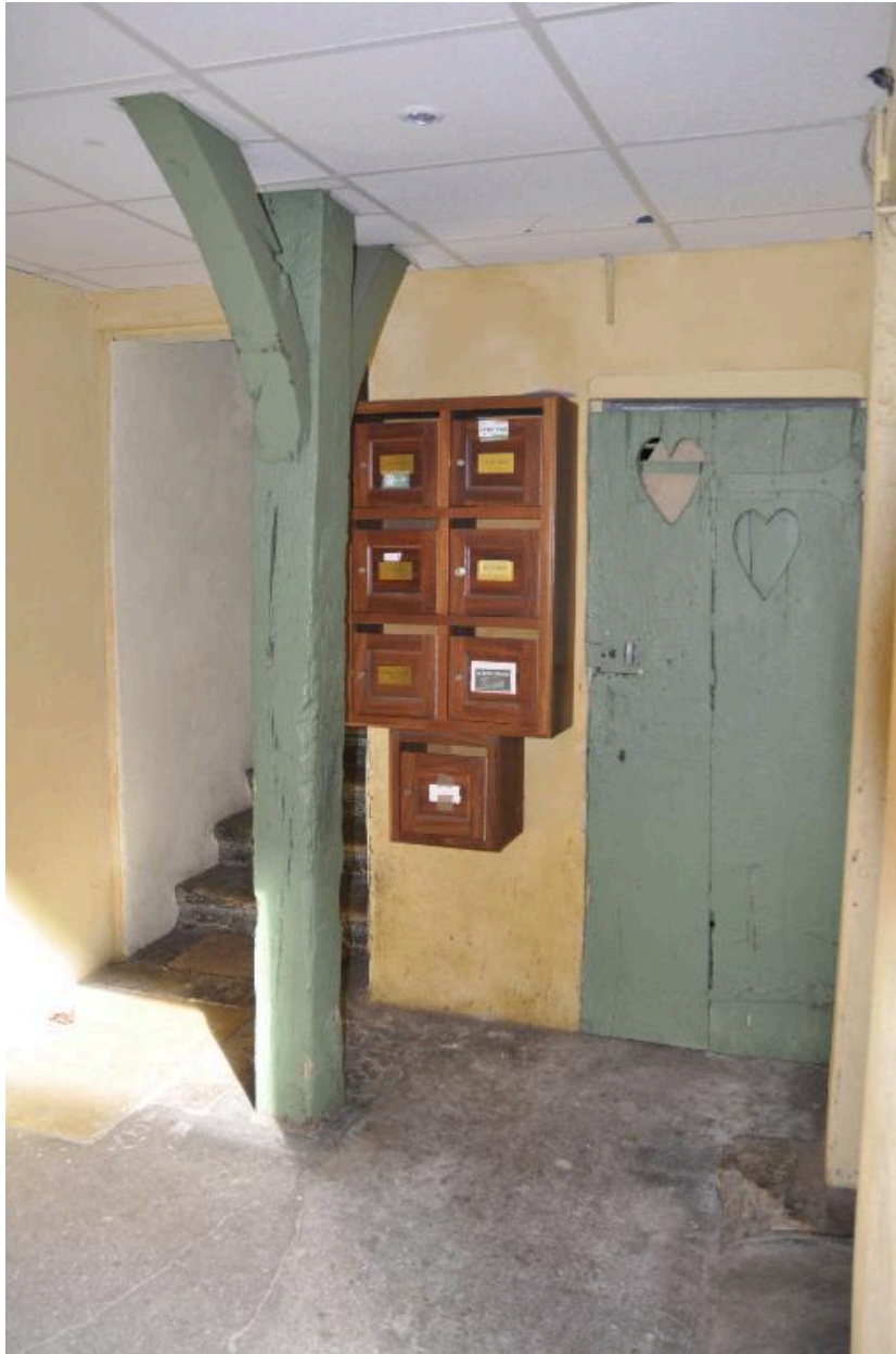
Vue du départ de l'escalier de l'immeuble sur rue
