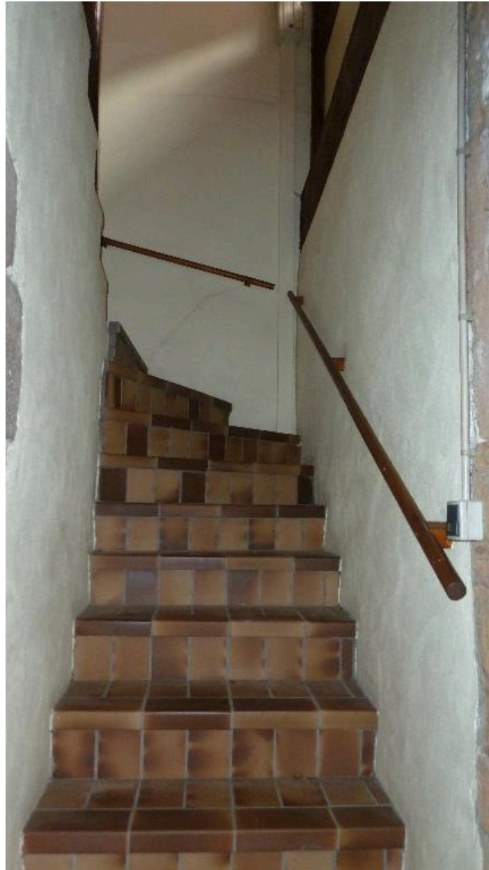
Vue de l'escalier de l'immeuble sur rue depuis le repos
