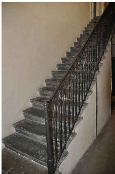
Vue du départ de de l'escalier de l'immeuble sur cour Phot. Nadine Halitim-Dubois IVR82_20146900350NUCA
