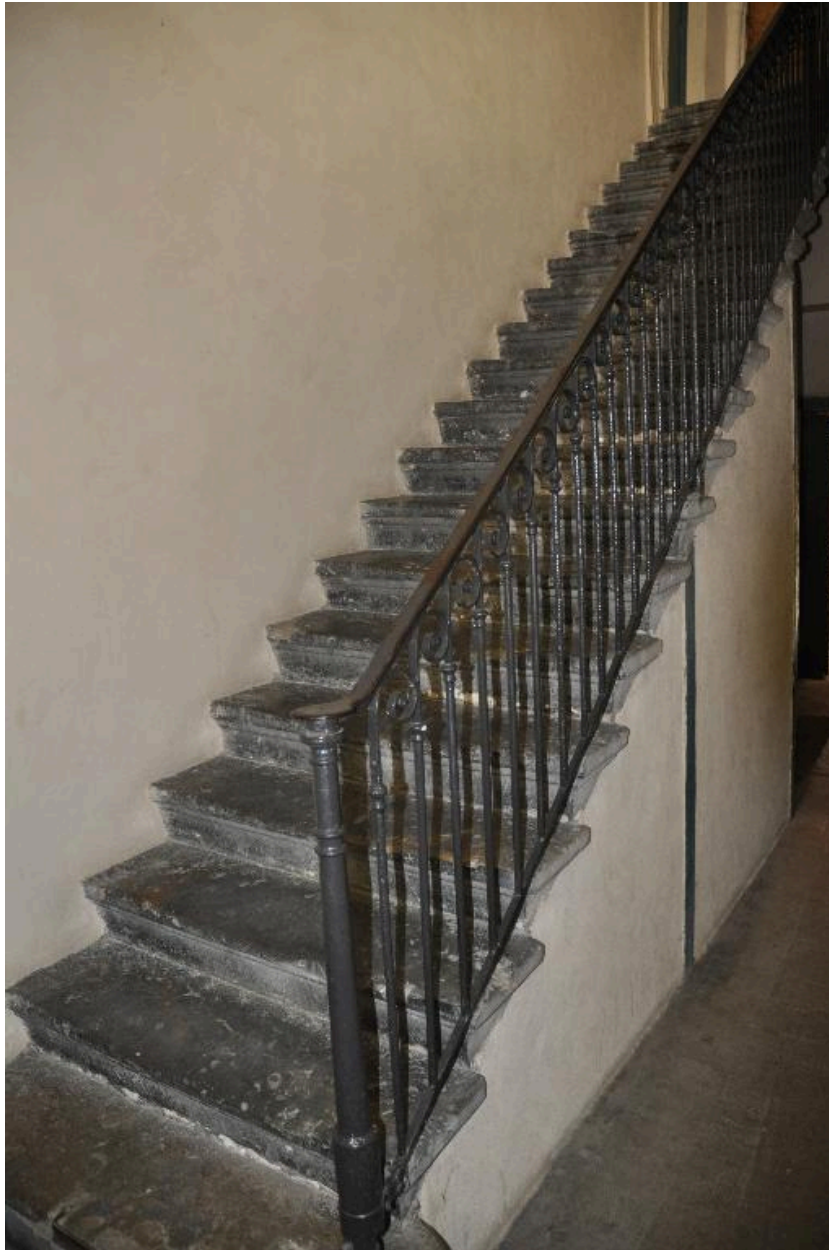
Vue du départ de de l'escalier de l'immeuble sur cour
