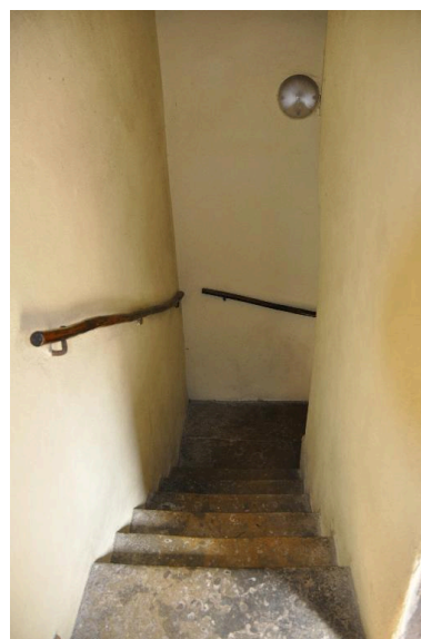
Vue de l'escalier de l'immeuble sur rue depuis le palier Phot. Nadine Halitim-Dubois IVR82_20146900348NUCA
