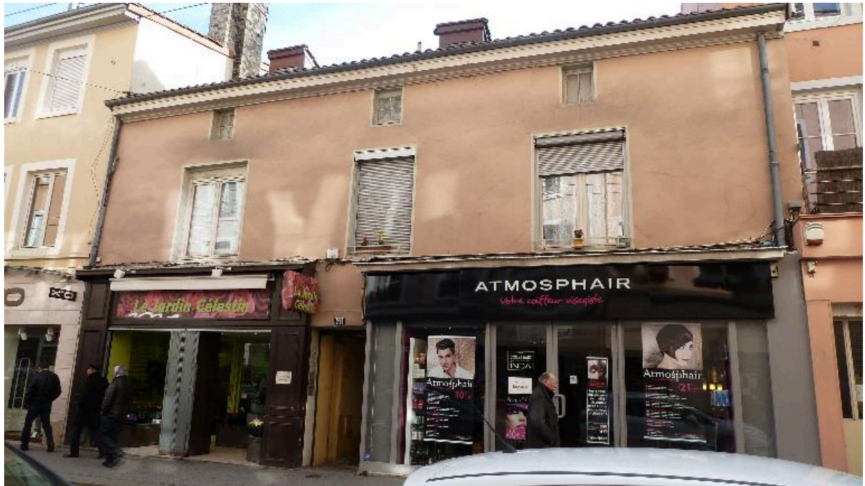
Vue d'ensemble sud ouest
