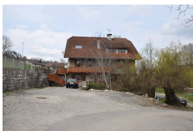
Vue de la façade latérale sud prise depuis le chemin du moulin Phot. Samir Mahfoudi, Autr. Samir Mahfoudi IVR82_20107400182NUCA
