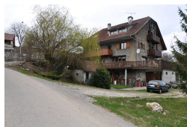
Vue de l'élévation sud-est prise depuis le chemin du moulin Phot. Samir Mahfoudi, Autr. Samir Mahfoudi IVR82_20107400183NUCA
