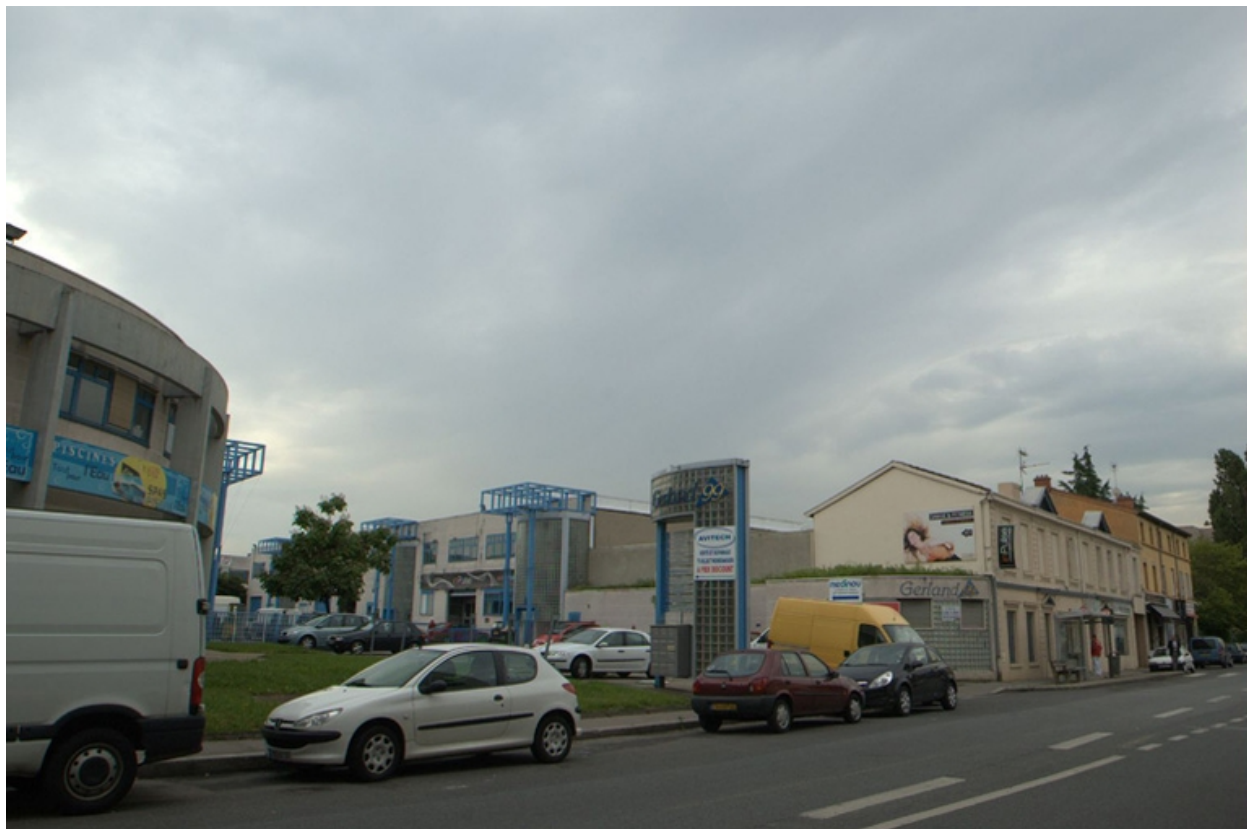
Vue d'ensemble de l'ancienne parcelle Olida
