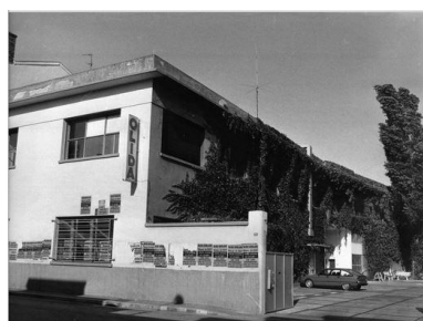
Vue du bâtiment administratif (BM Lyon) Phot. BM Lyon IVR82_20136900934NUC
