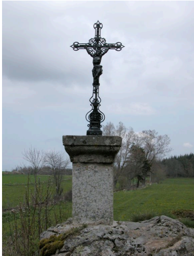
Vue générale Phot. Thierry Monnet IVR82_20114201771NUCA
