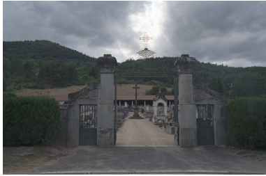
Vue d'ensemble du portail d'entrée du cimetière. Phot. Thierry Monnet IVR82_20034200761ZE
