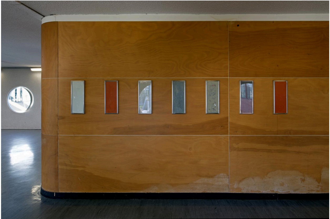
Mur n° 4, vue d'ensemble.
