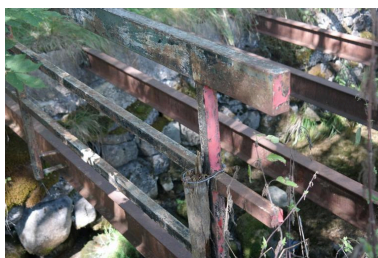
Passerelle de la Chapelle d'Abondance, détail structure Phot. Pascale Renard IVR84_20207400928NUCA
