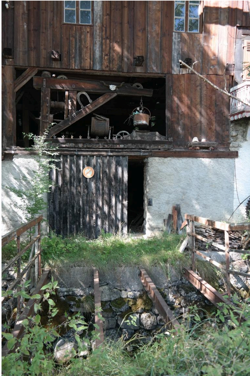
Vue générale de la Passerelle de la Chapelle d'Abondance
