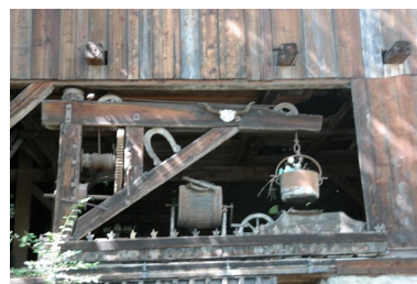
Détail de la grange du bâtiment en face de la passerelle : système de levage Phot. Pascale Renard IVR84_20207400929NUCA
