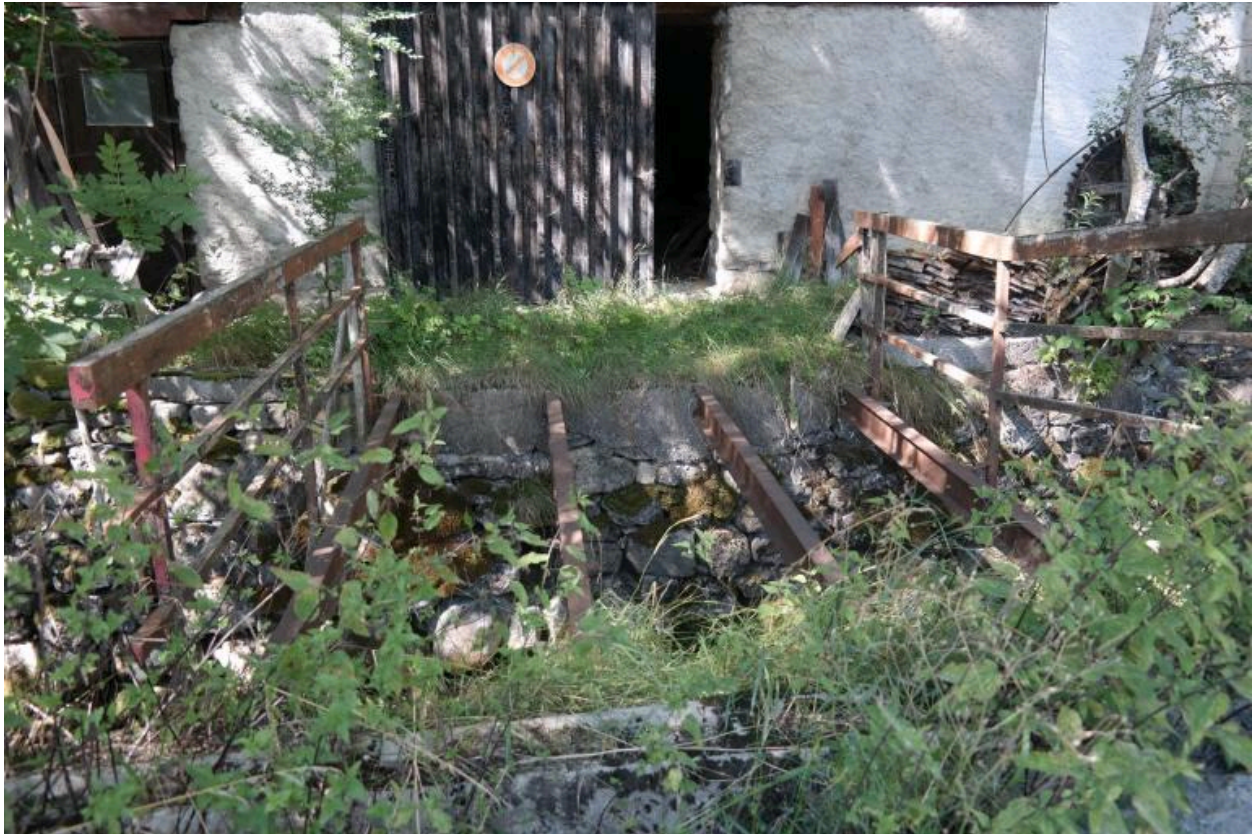
Passerelle de la Chapelle d'abondance et porte de grange
