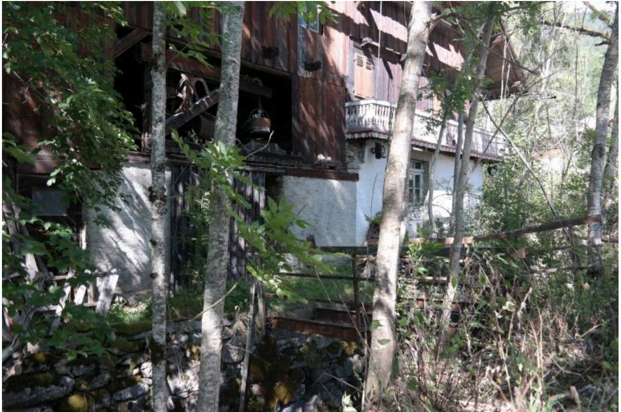
Passerelle de la Chapelle d'Abondance, vue face aval
