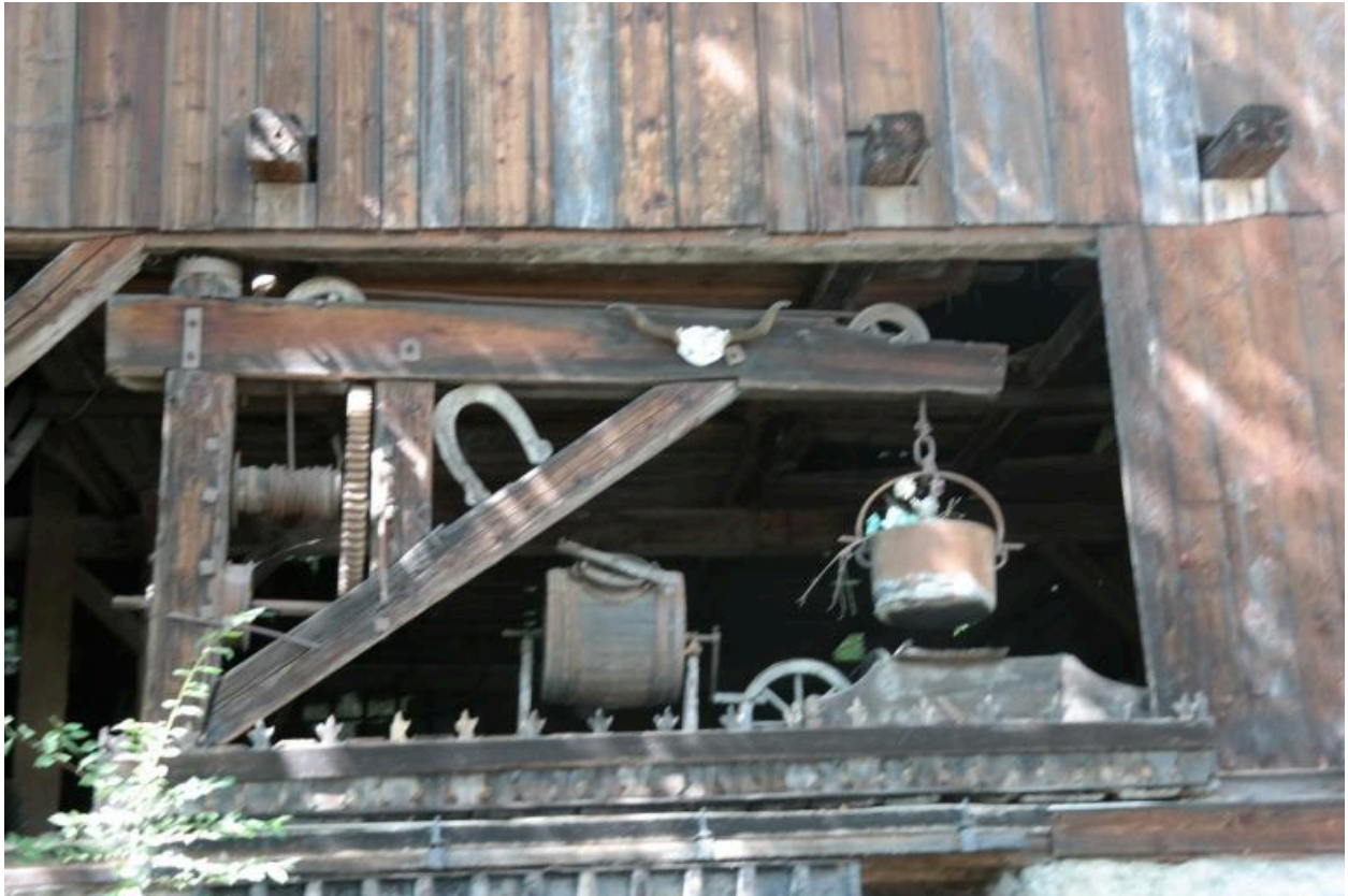
Détail de la grange du bâtiment en face de la passerelle : système de levage
