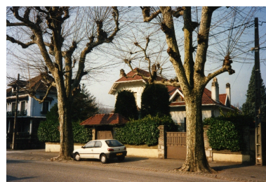
Vue depuis la rue Repro. François Fouger IVR82_20117300718NUCB
