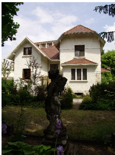
Façade postérieure sur jardin Phot. François Fouger IVR82_20097300612NUCA
