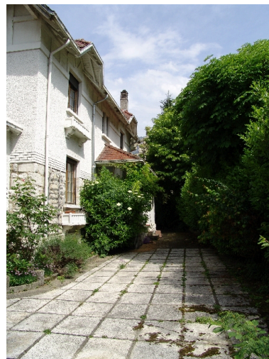
Façade latérale gauche Phot. François Fouger IVR82_20097300609NUCA
