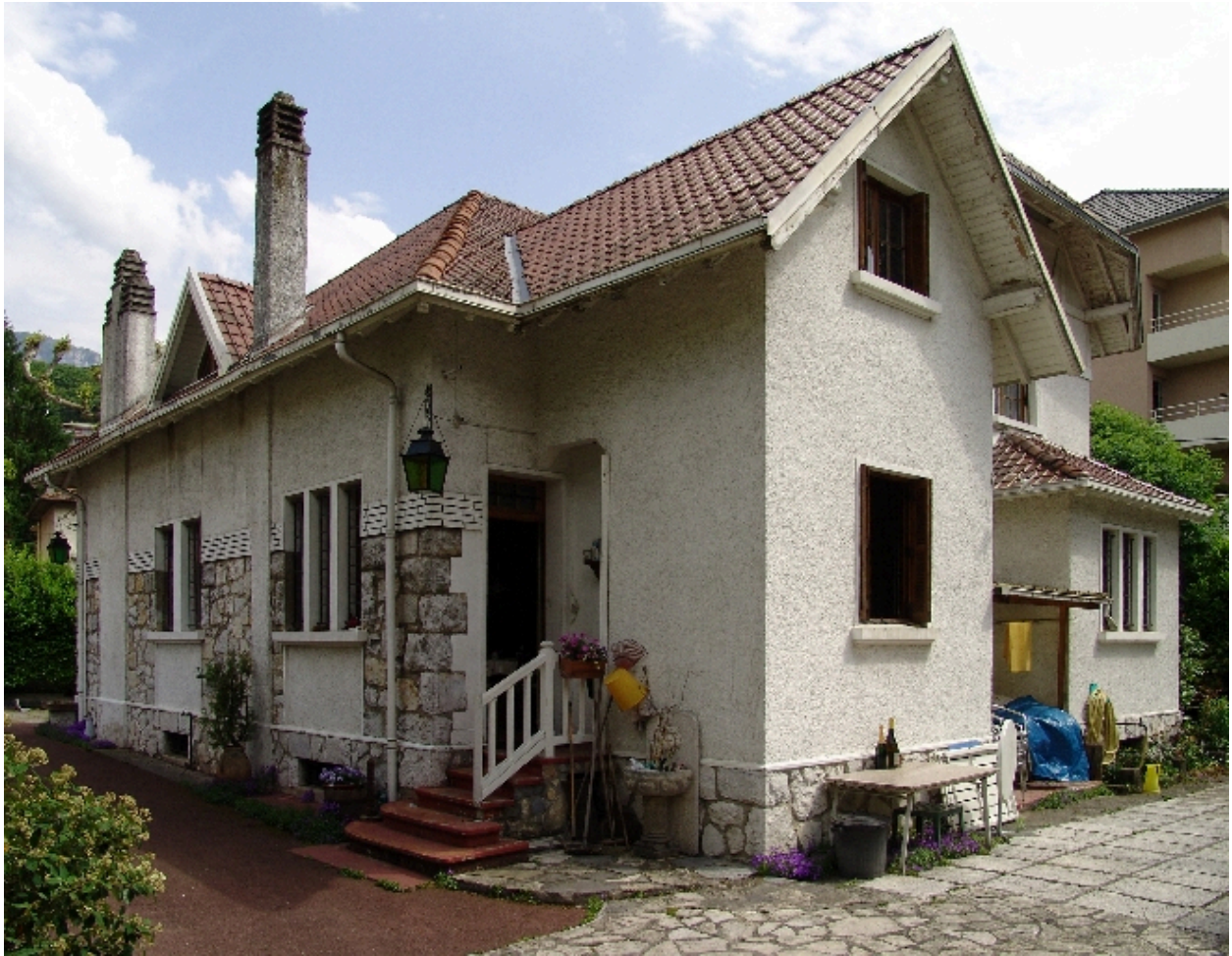
Façades postérieure et latérale droite
