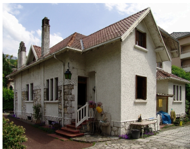
Façades postérieure et latérale droite Phot. François Fouger IVR82_20097300614NUCA
