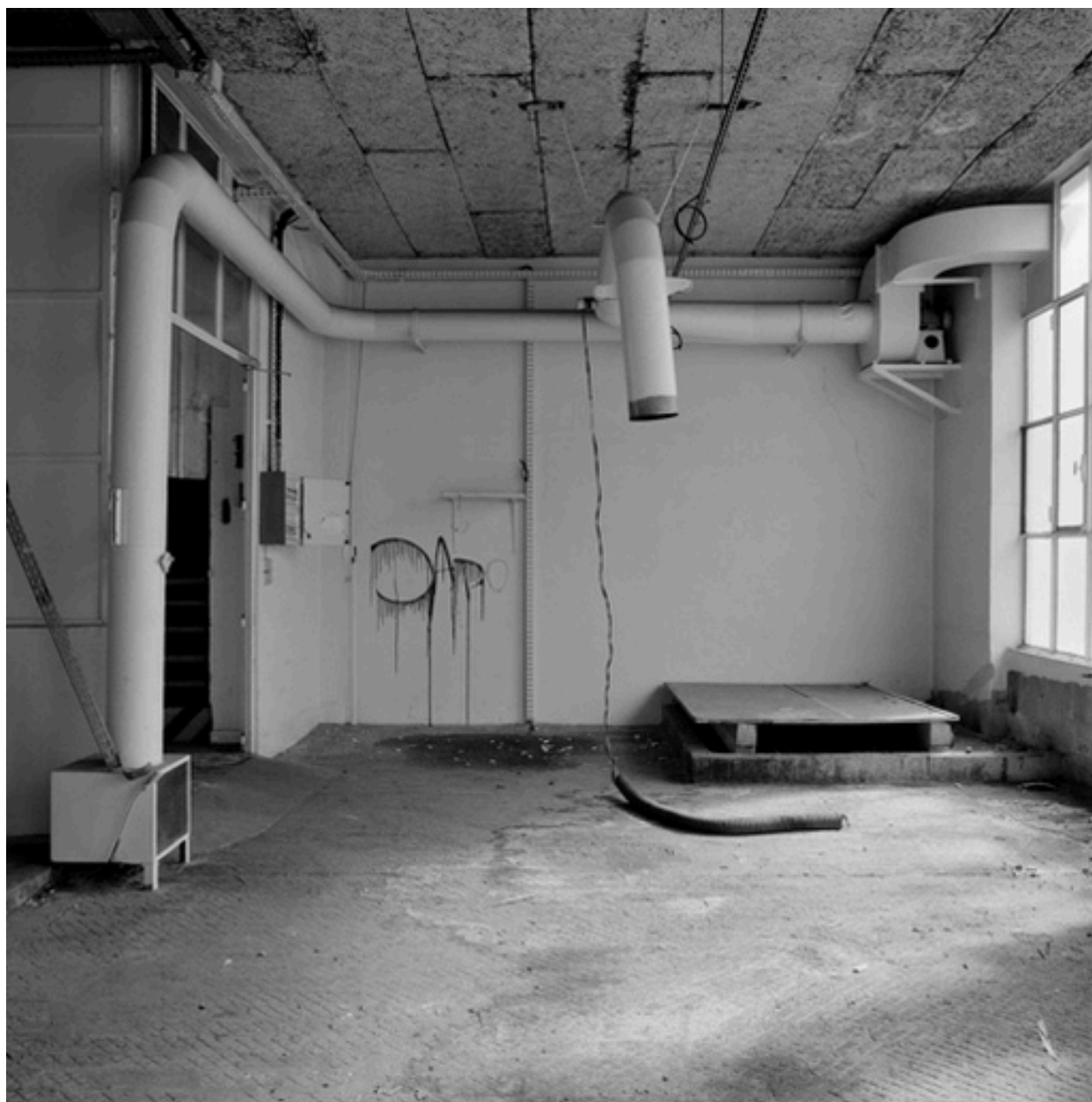
Struture de ventilation
