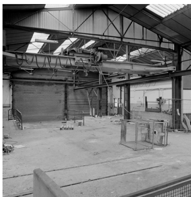
Extension construit en 1960 Phot. Eric Dessert IVR82_20066902843X
