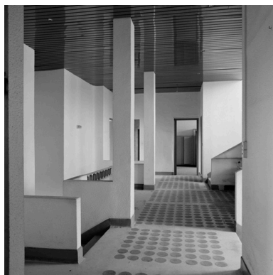
Hall d'entrée, 1er étage, dalles avec cabochons de verre transparent au sol Phot. Eric Dessert IVR82_20066902836X
