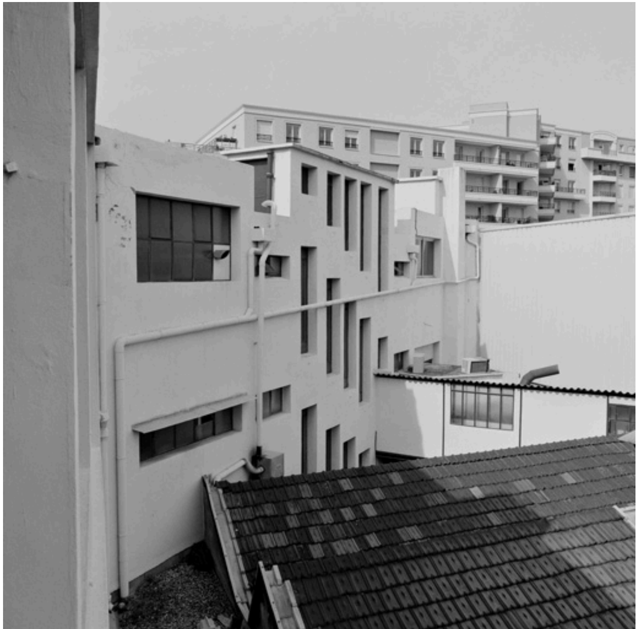
Façade sud-est, escalier
