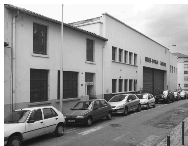
Détail façade nord-est de 1962. Phot. Didier Gourbin IVR82_20076900847NUC
