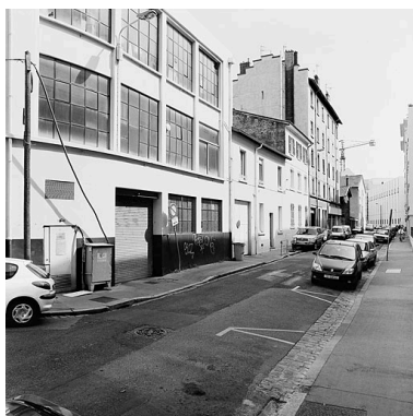
Vue ouest Phot. Didier Gourbin IVR82_20046902630X
