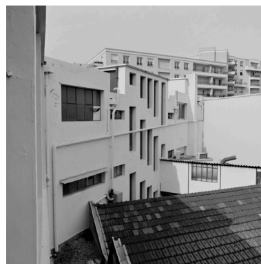
Façade sud-est, escalier Phot. Eric Dessert IVR82_20066902855X
