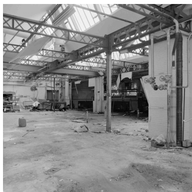
Vue intérieure des ateliers Phot. Eric Dessert IVR82_20066902842X
