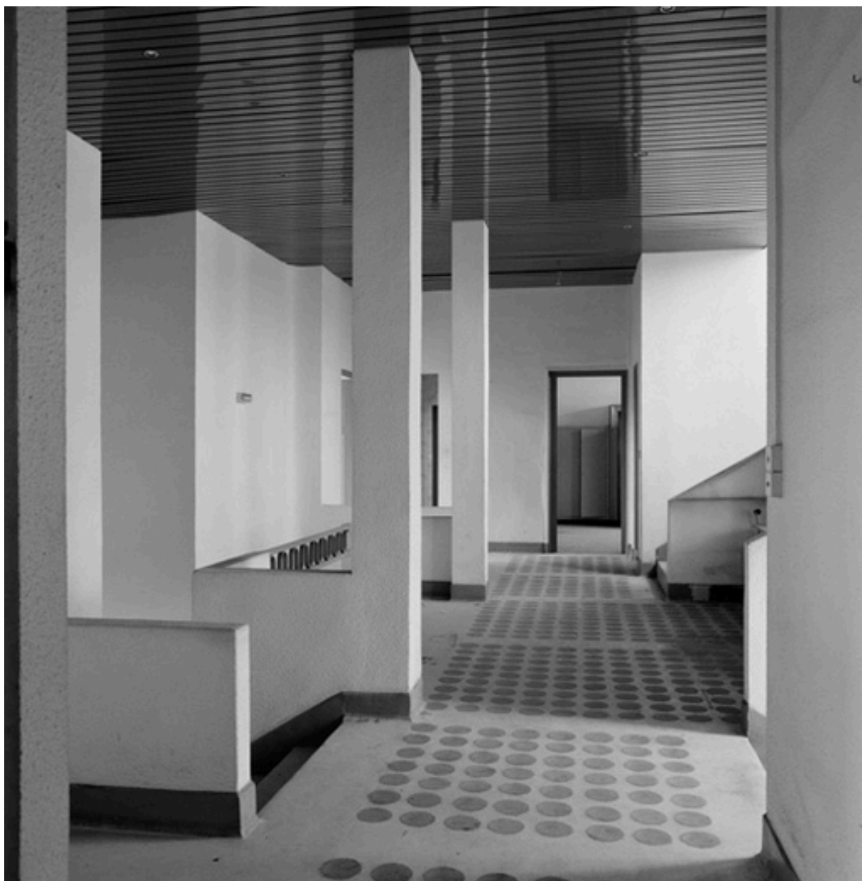
Hall d'entrée, 1er étage, dalles avec cabochons de verre transparent au sol
