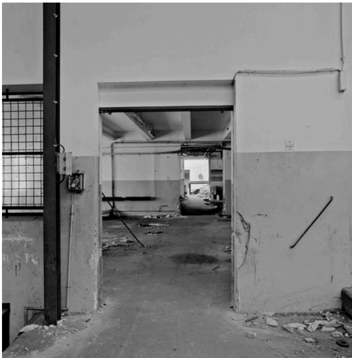
Vue d'ensemble des ateliers du second étage
