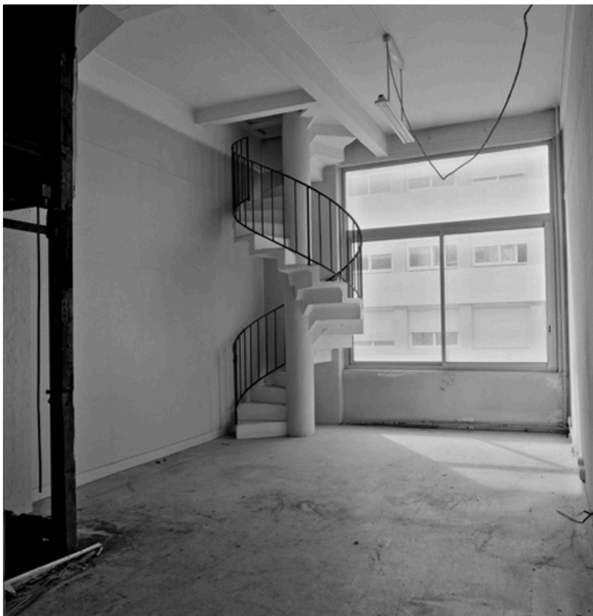
Escalier en vis menant aux combles
