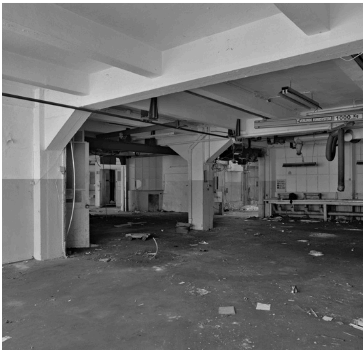
Vue d'ensemble atelier du second étage
