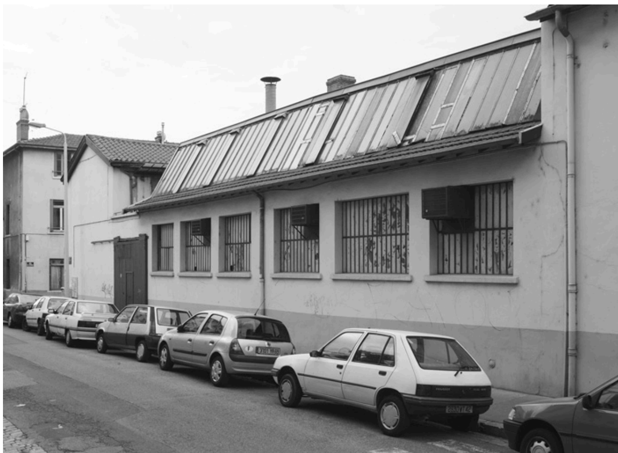
Façade des ateliers nord
