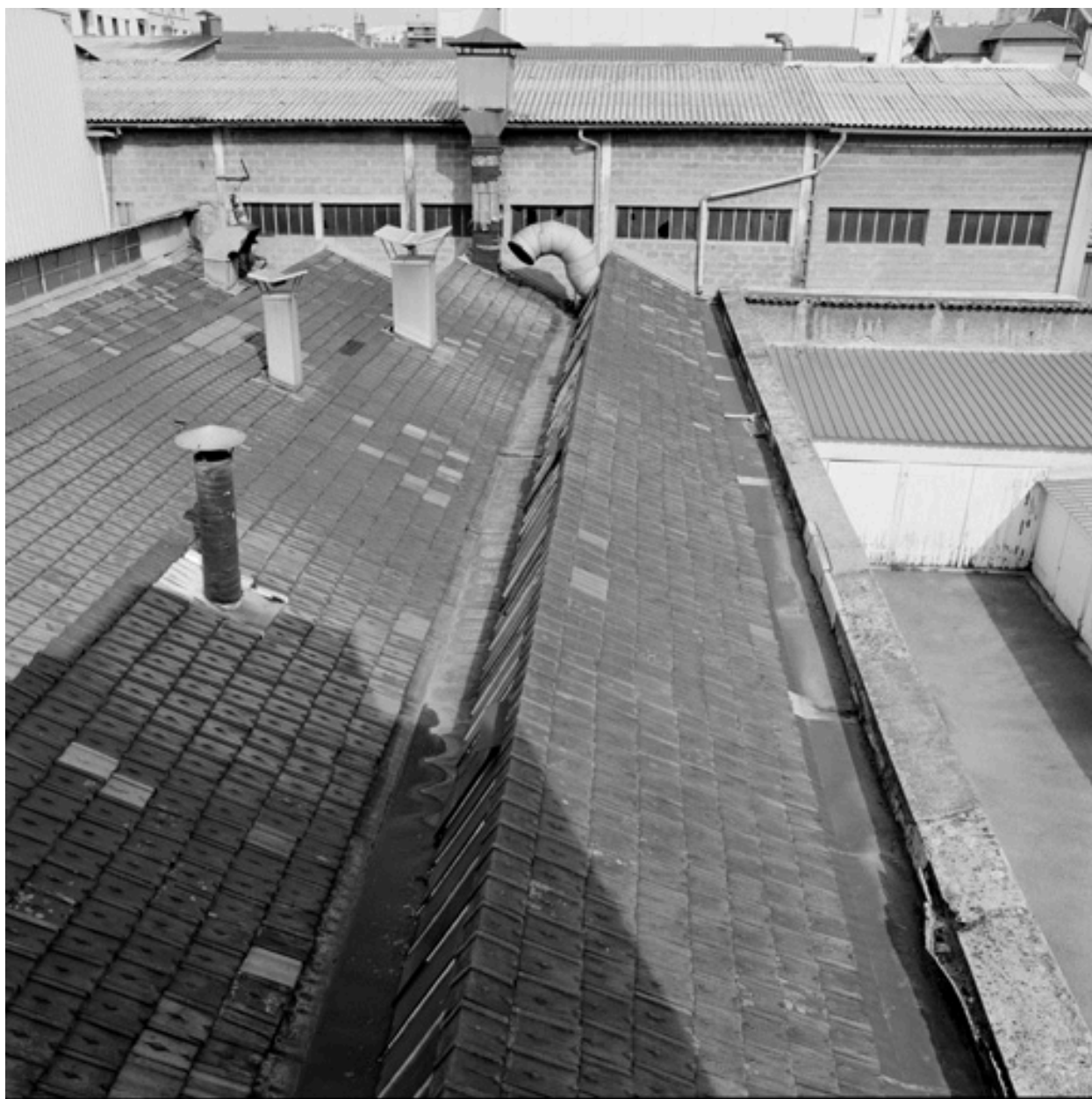
Vue sud-est des toits sheds
