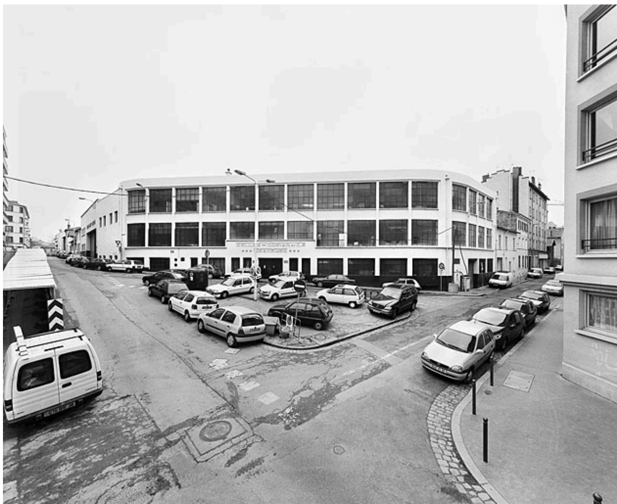
Vue générale nord
