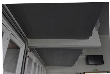
Détail du surplomb sur le préau de la salle dite "foyer-expositions" sur les plans, assuré par une "suspensoir en ciment armé". On peut noter le détail du chanfrein à congé, rare pour une pièce en béton de cette époque. Phot. Bénédicte Renaud-Morand IVR84_20226301724NUCA
