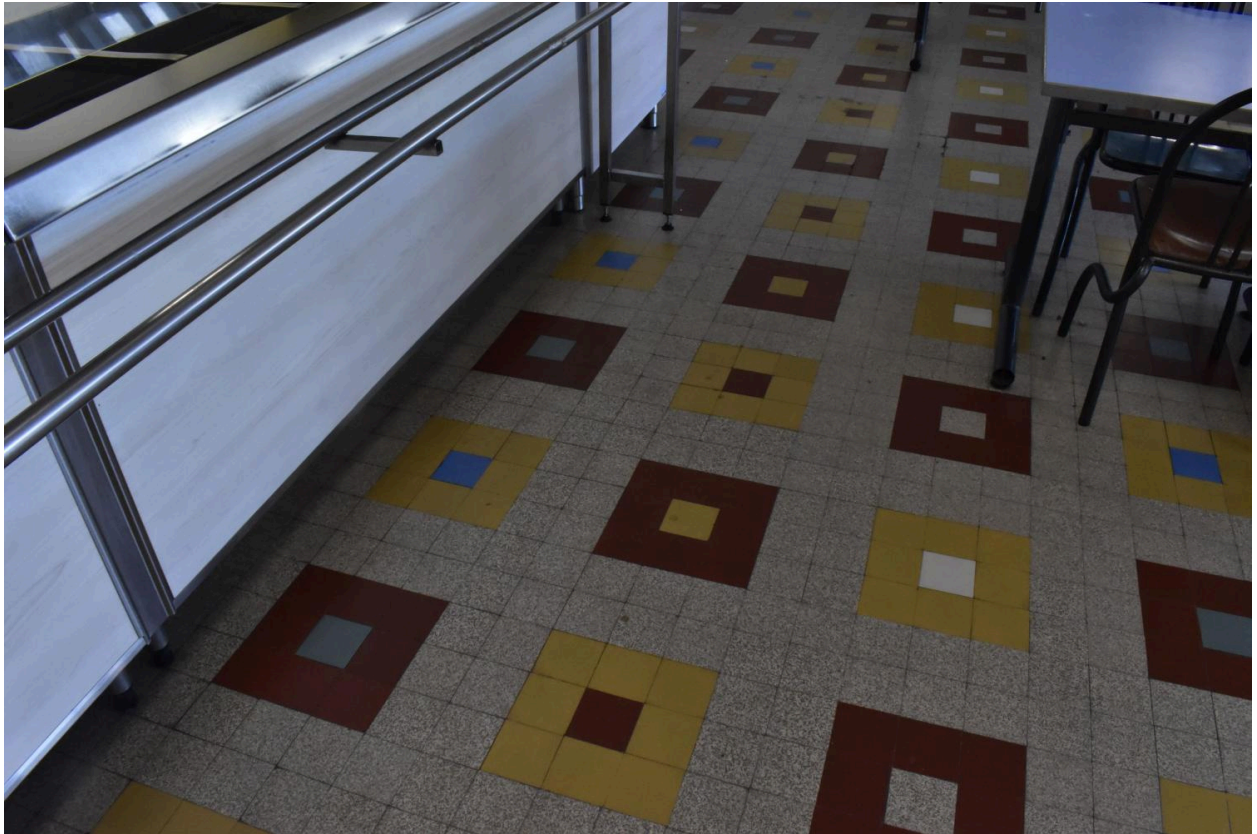
Carrelage en grès cérame de l'entreprise Jean Tomada de Bort-les-Orgues : une grande variété de dessins anime les sols de l'établissement. Ici, sol de la partie initialement dévolue au "réfectoire 100 élèves".
