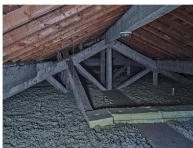
Charpente de toit en "béton de ciment armé", couvrant le bâtiment principal. (L'aile de l'internat est couverte d'une charpente en sapin.) Phot. Christian Parisey IVR84_20226301705NUCA
