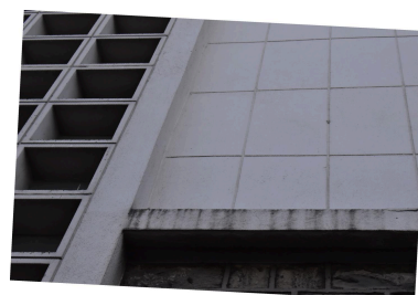
Façade principale sur le boulevard. Sur ce détail, on distingue les faux joints tracés sur le "crépissage au mortier de ciment et peinture silexore" (termes d'un courrier de l'architecte à l'inspecteur principal dans lequel A. Verdier décrit une "solution de pauvreté"). Phot. Bénédicte Renaud-Morand IVR84_20226301741NUCA
