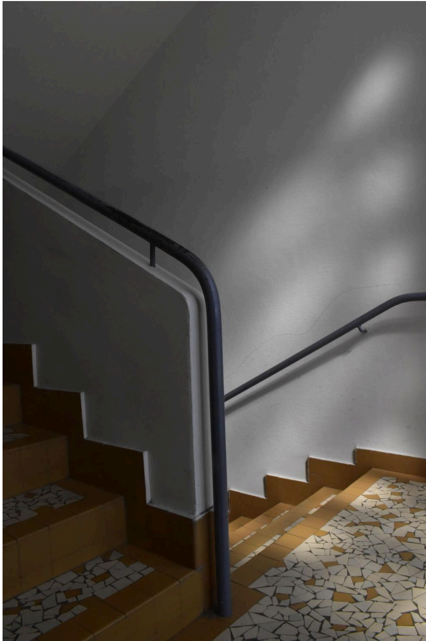
Escalier rampe-sur-rampe, situé à l'est du bâtiment principal, s'éclairant sur l'impasse du Moutier.
