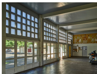
Grande salle, dite préau, s'éclairant sur la cour de récréation (il semblerait que les portes vitrées de la partie basse aient été ajoutées dans un second temps), avec fresque de Louis Dussour sur le mur ouest (1% artistique). Le sol est d'asphalte rouge, tel que prévu sur les plans d'André Verdier. Phot. Christian Parisey IVR84_20226301704NUCA
