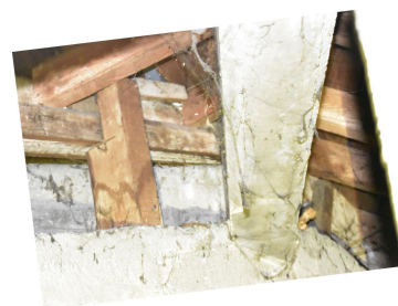
Charpente de toit en béton, faitage : gros plan sur un chanfrein à congé (détail de modénature que l'on peut repérer à différents endroits dans l'établissement). Phot. Bénédicte Renaud-Morand IVR84_20226301725NUCA
