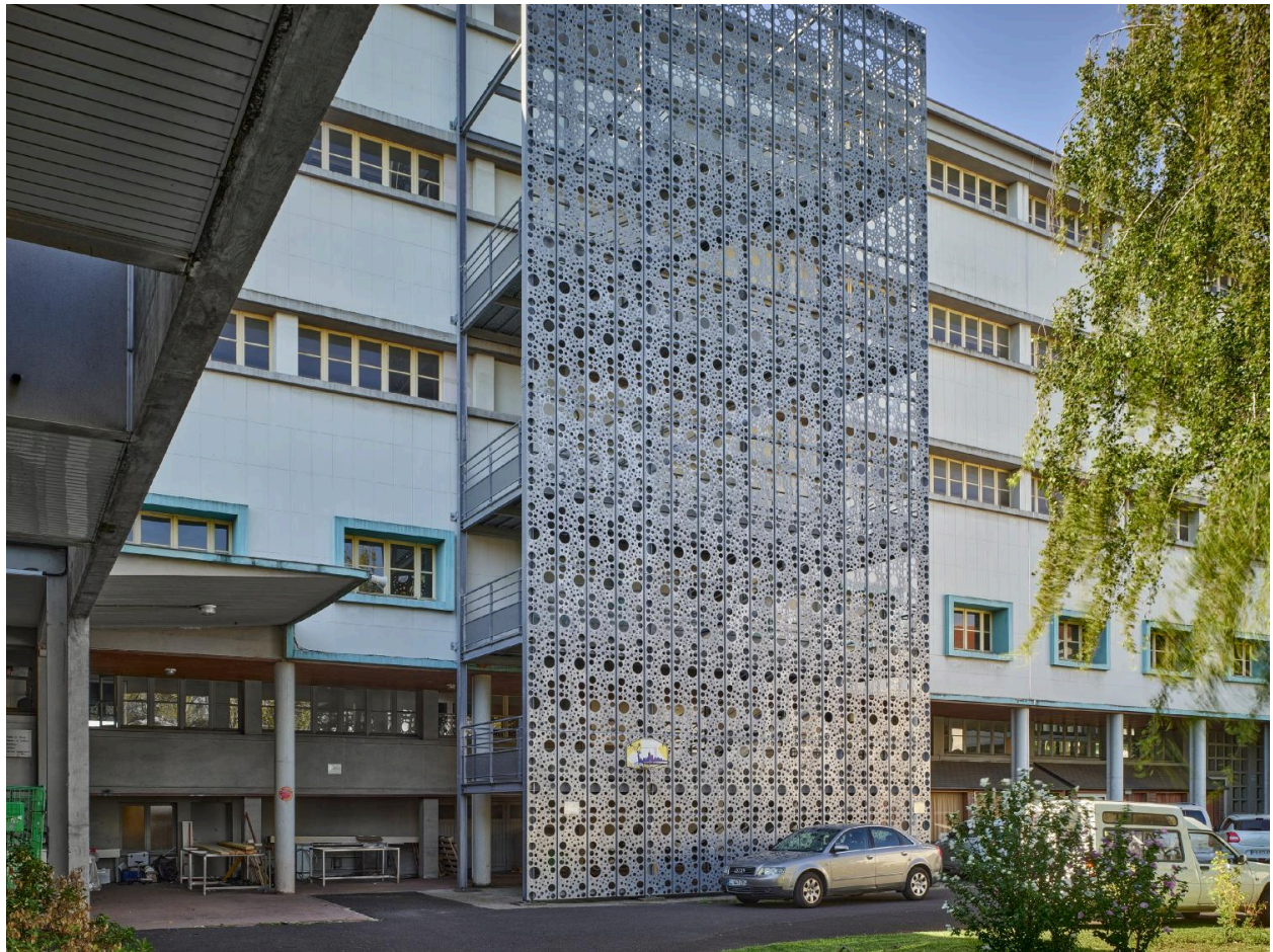
Elévation nord du bâtiment principal, flanqué d'un escalier de secours du début du 21e siècle.
