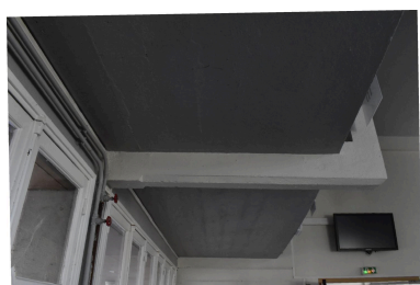
Détail du surplomb sur le préau de la salle dite "foyer-expositions" sur les plans, assuré par une "suspente en ciment armé". On peut noter le détail du chanfrein à congé, rare pour une pièce en béton de cette époque. Phot. Bénédicte Renaud-Morand IVR84_20226301724NUCA
