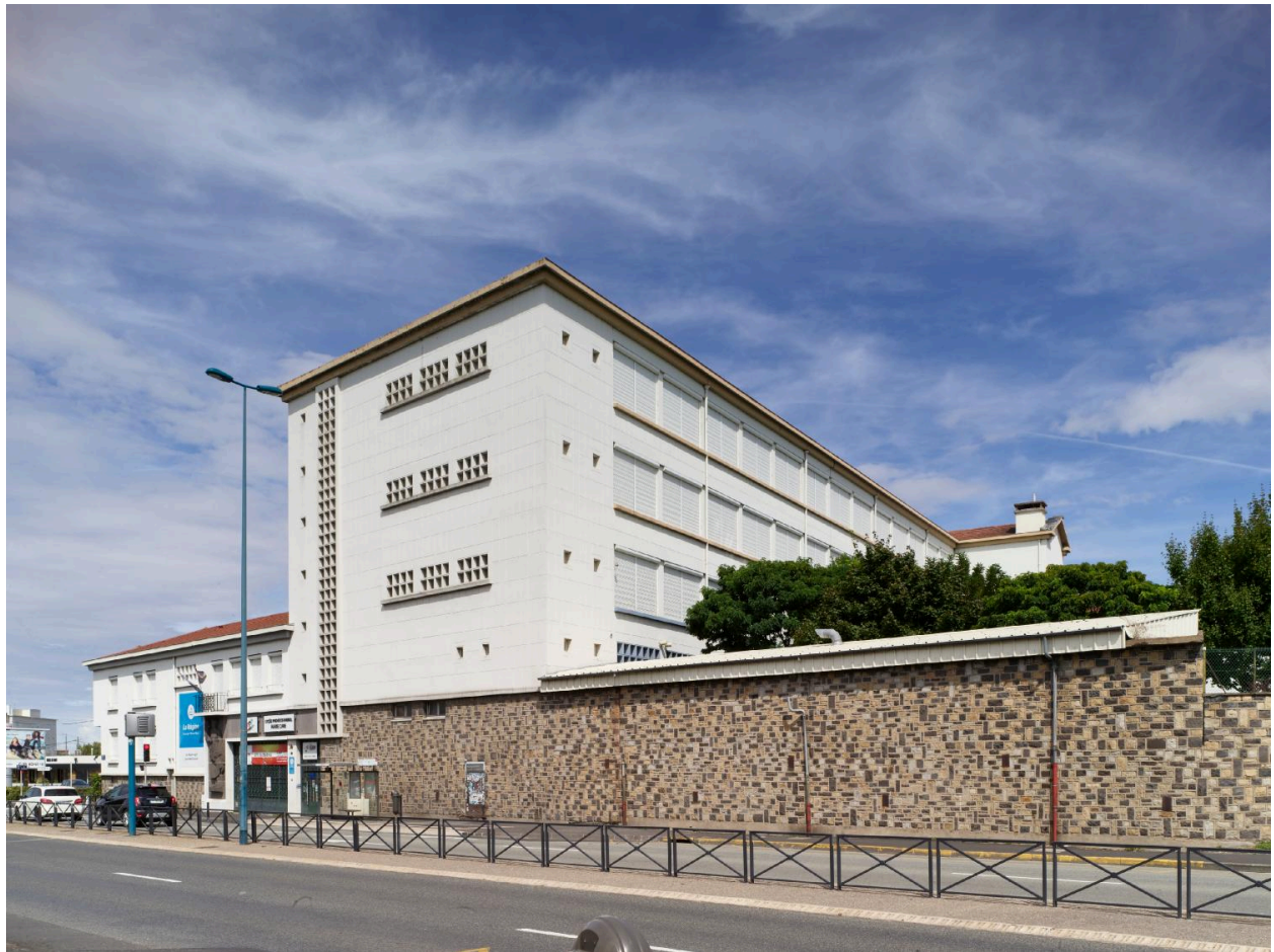
Façade principale avec mur de soutènement du remblai correspondant à la cour de récréation.
