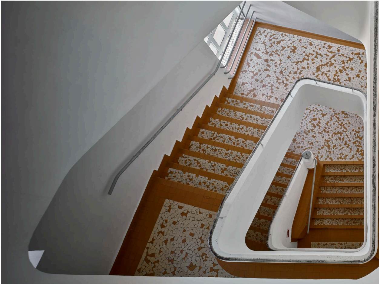
Escalier tournant suspendu, éclairé par la travée de claustras de la façade principale sur le boulevard.
