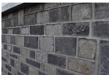
Cette partie de mur correspond aux termes du devis "maçonnerie de moellons apparents de Volvic et granit mélangés, compris joints à ruban en béton de ciment coffré". Il a été réalisé par l'entreprise Pinardel de Tulle. Phot. Bénédicte Renaud-Morand IVR84_20226301740NUCA
