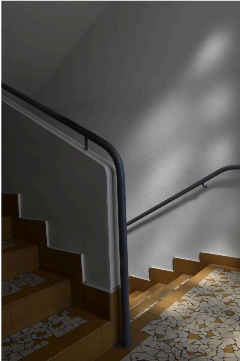
Escalier rampe-sur-rampe, situé à l'est du bâtiment principal, s'éclairant sur l'impasse du Moutier.
