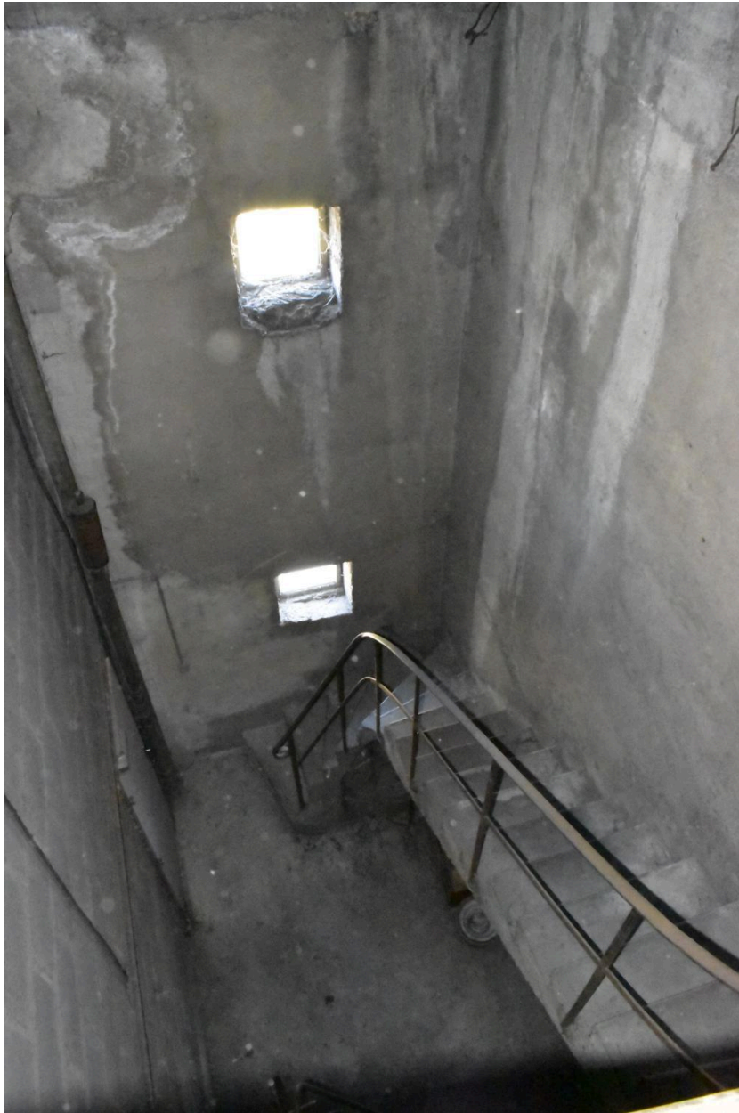
Escalier d'accès à la charpente de toit du bâtiment principal, avec un départ au troisième étage.
