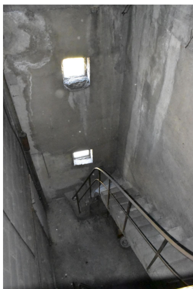
Escalier d'accès à la charpente de toit du bâtiment principal, avec un départ au troisième étage. Phot. Bénédicte Renaud-Morand IVR84_20226301726NUCA
