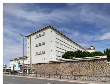
Façade principale avec mur de soutènement du remblai correspondant à la cour de récréation. Phot. Christian Parisey IVR84_20226304447NUC4A
