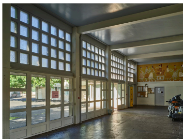
Grande salle, dite préau, s'éclairant sur la cour de récréation (il semblerait que les portes vitrées de la partie basse aient été ajoutées dans un second temps), avec fresque de Louis Dussour sur le mur ouest (1% artistique). Le sol est d'asphalte rouge, tel que prévu sur les plans d'André Verdier. Phot. Christian Parisey IVR84_20226301704NUCA
