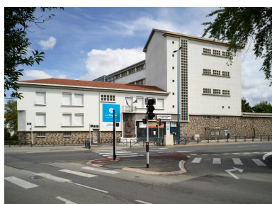
Façade principale sur le boulevard. La présence du balcon au-dessus du haut-relief est intrigante puisqu'elle lui fait de l'ombre, et cela d'autant plus que le balcon correspond à la salle de séjour de l'appartement privé de la directrice.
