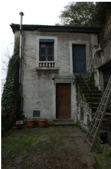
Logis sud, façade sur cour
