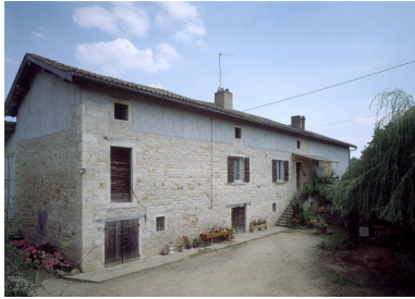
Elévation antérieure sur cour : dépendances agricoles et logis.
