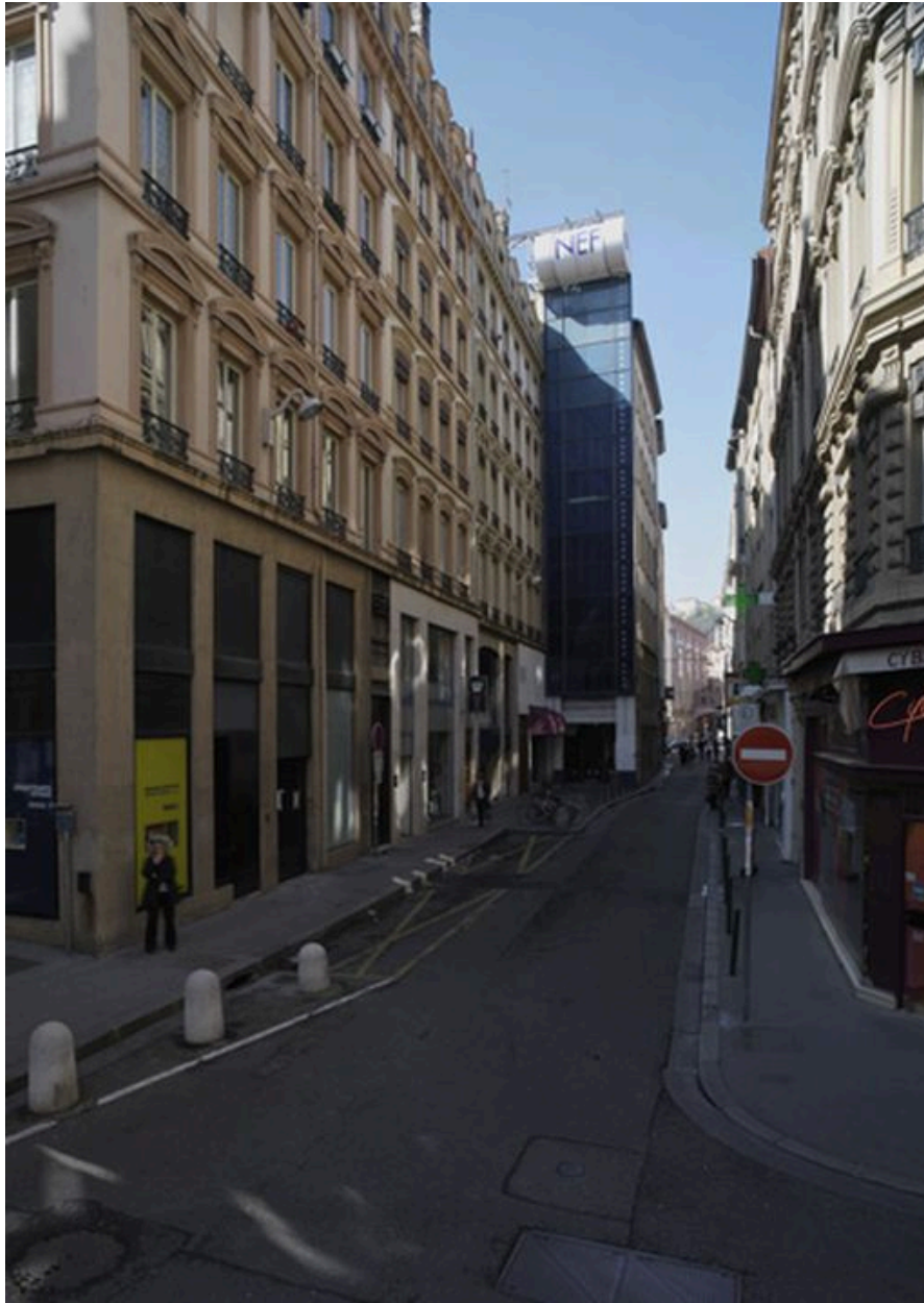
Vue depuis l'est (rue de la République)
