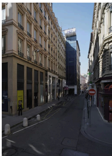
Vue depuis l'est (rue de la République) Phot. Eric Dessert IVR82_20086901018NUCA
