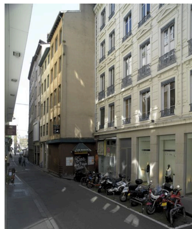
Vue depuis l'ouest (rue du Président-Edouard-Herriot) Phot. Eric Dessert IVR82_20086901023NUCA
