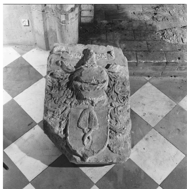
1e étage, grande salle : armoiries des Covet.
