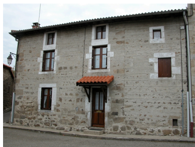
Vue d'ensemble du logis (façade sud). Phot. Caroline Guibaud IVR82_20124200855NUCA
