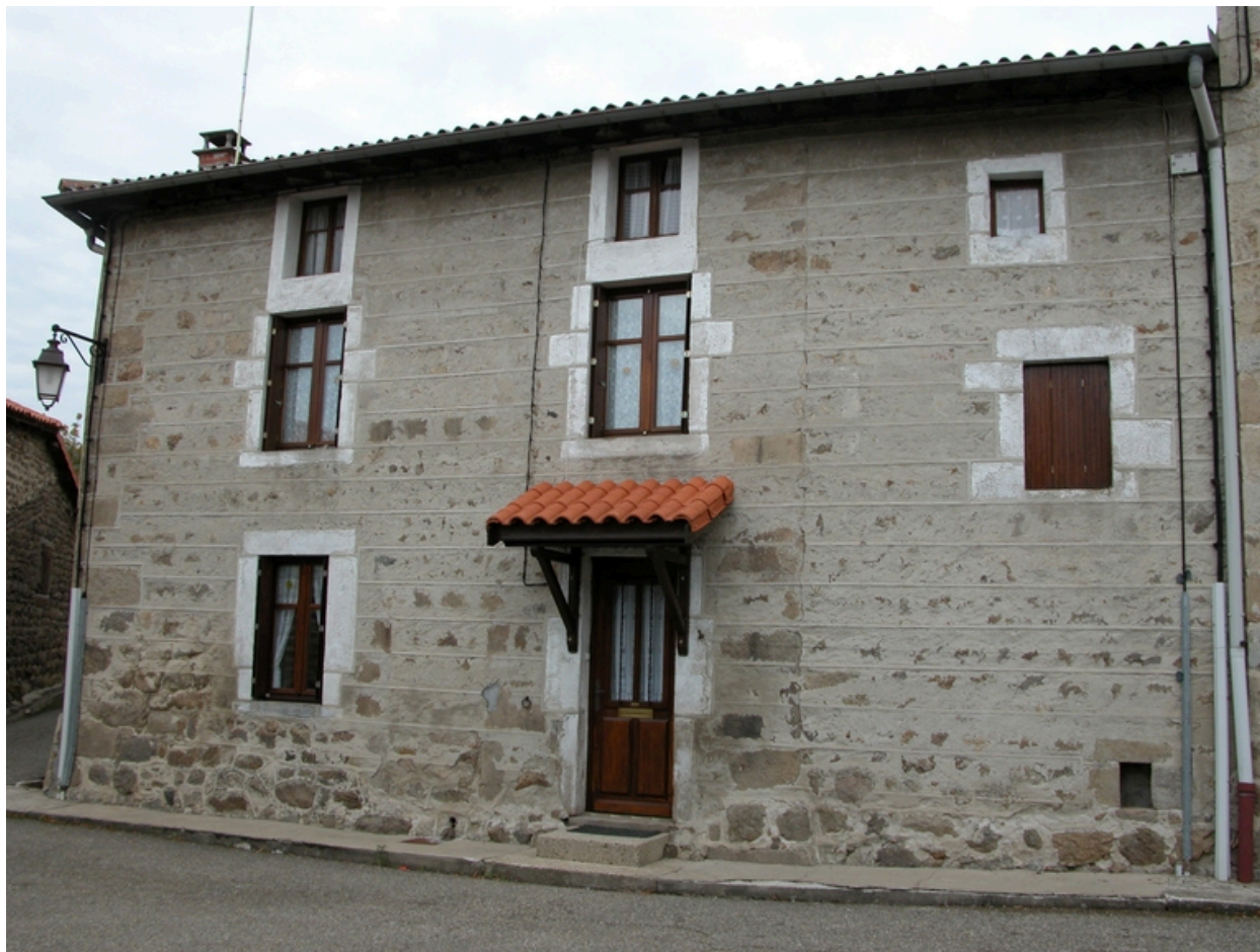
Vue d'ensemble du logis (façade sud).
