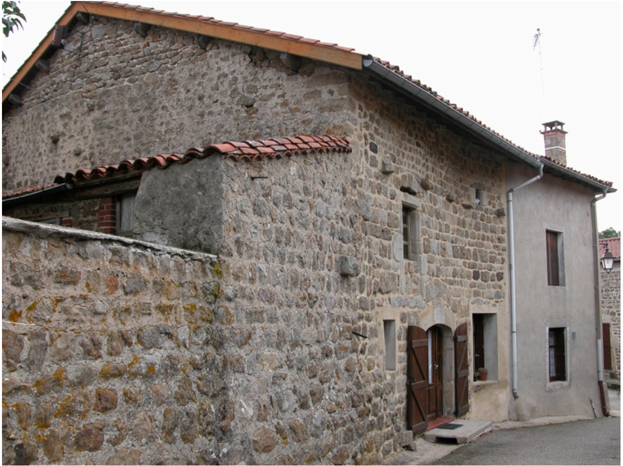
Vue d'ensemble de l'étable et de l'angle du logis (élévation ouest), depuis le nord-ouest.
