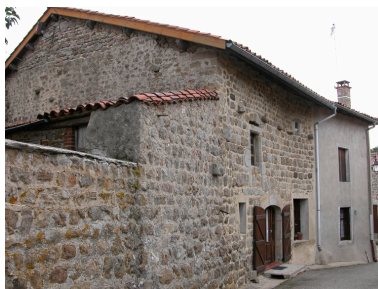
Vue d'ensemble de l'étable et de l'angle du logis (élévation ouest), depuis le nord-ouest. Phot. Caroline Guibaud IVR82_20124200856NUCA
